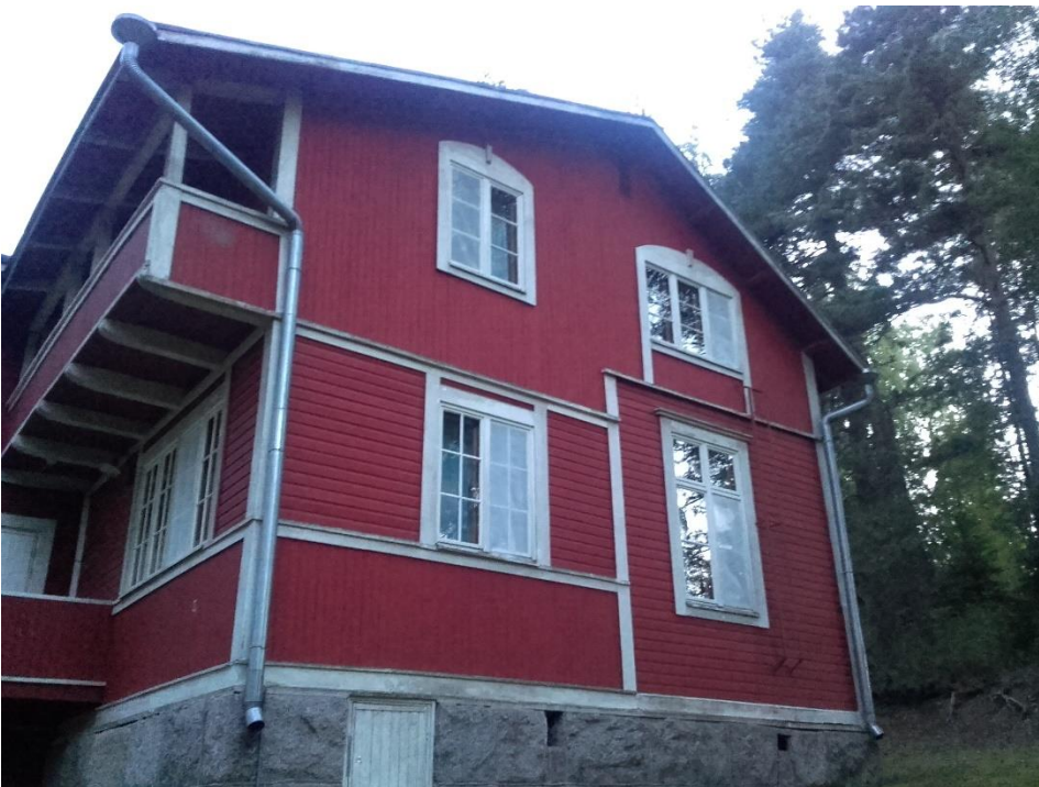
Kuva 10. Toinen osa viiksi/isoviiksisipiipojen yhdyskunnasta sijaitsi tässä rakennuksessa. Rakennuksen vintille ei ollut pääsyä. Yhteensä 25 yksilöä lähti rakennuksesta lentoon, joista pääosa yhdestä kolosta räystäään alla aivan katon harjassa, kuvassa näkyvässä päädyssä.
