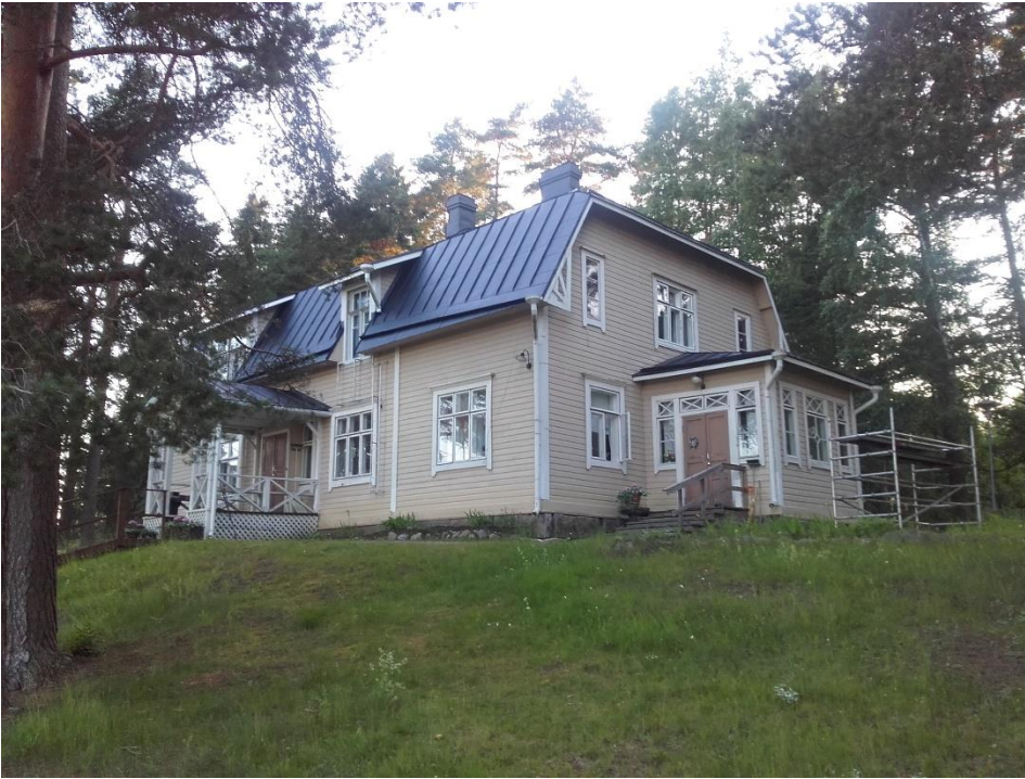
Kuva 9. Osa viiksi/isoviiksisipiipojen yhdyskunnasta sijaitsi tässä rakennuksessa. Rakennuksen vintillä nähtiin emoja poikasineen. Yhteensä 12 yksilöä lähti rakennuksesta lentoon useista koloista itäpäädyn räystäään alta.
