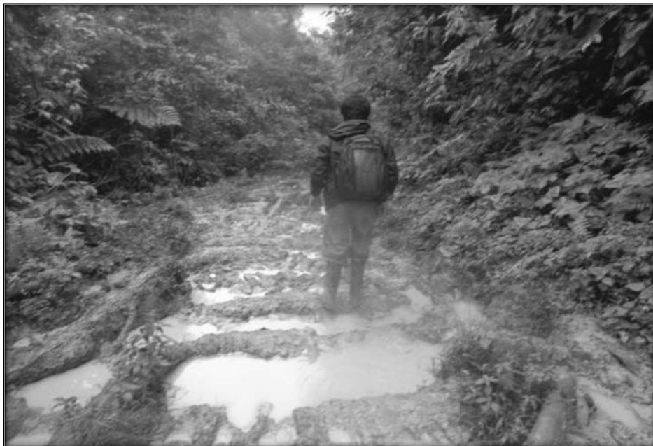
Fotografía N° 13: Mal estado del Camino al Anexo Villa Hermosa y otros anexos cercanos.
