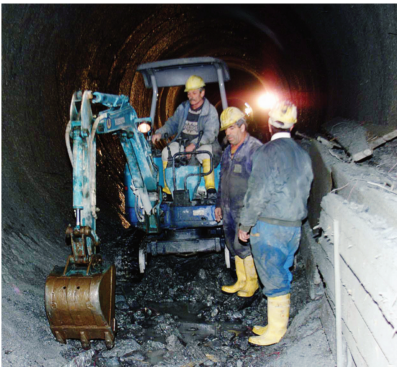
Operai al lavoro nel by-pass di Spriana nel 2008. Il cantiere è ormai in stato di abbandono da quindici anni
