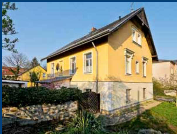
Einfamilienhaus in Dresden, Pos. 90
