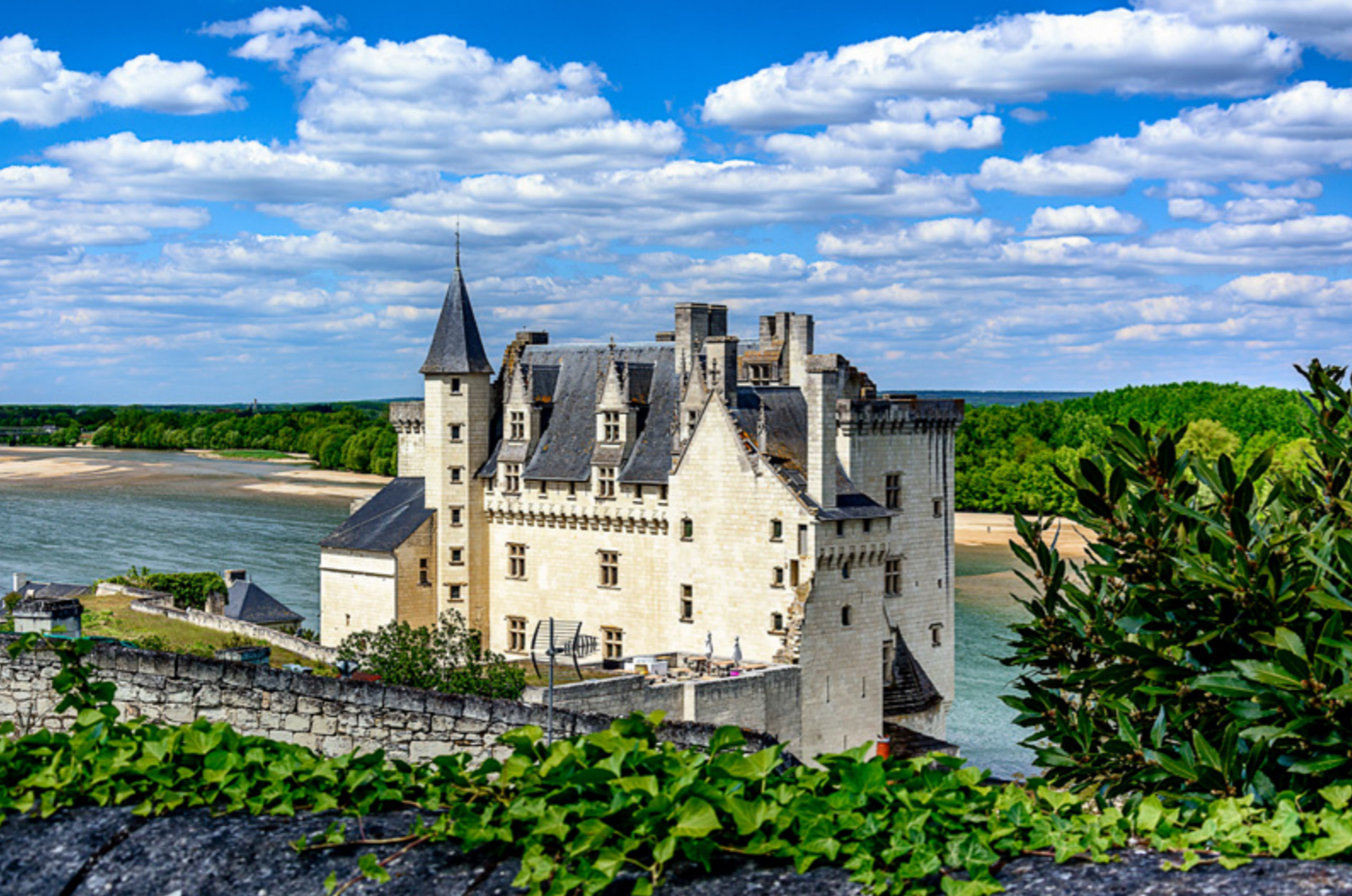
Château de Montsoreau
