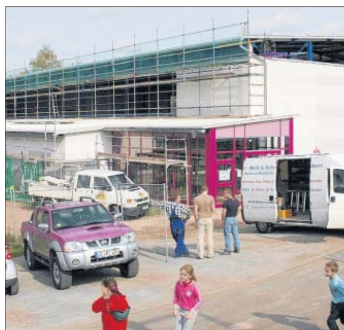
Vorgestern wurde in der neuen BBC-Sporthalle im Flickschupark Richtfest gefeiert. Blau-lila ist die Krone, die über dem Eingang hängt, geschmückt. Diese Farben spiegeln sich künftig auch in dem Bau wieder. Ende des Jahres soll die knapp 2,1 Millionen Euro teure Halle eingeweiht werden. Dann können auch die Schüler des Gymnasiums hier ihren Sportunterricht absolvieren. Fotos (2): Anja Guse
