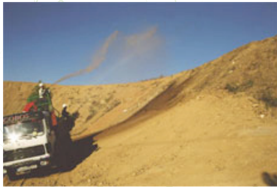
Ilustración 14 Riego en talud restaurado
