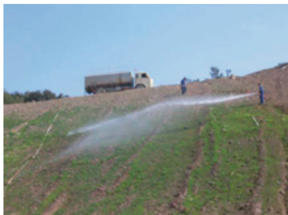
Ilustración 33 Riego apoyo en zonas restauradas
