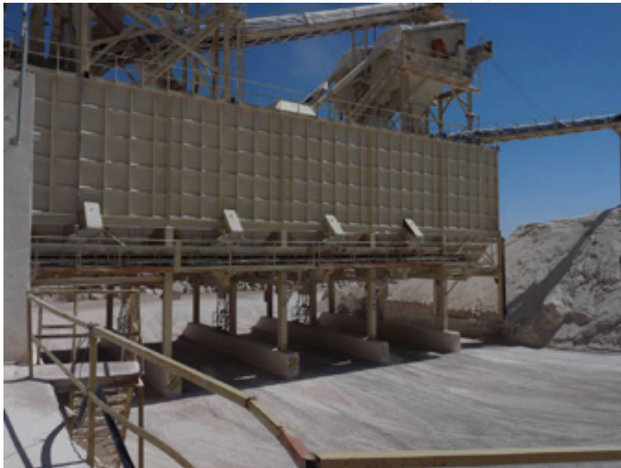
Ilustración 48 Acopio en silos
