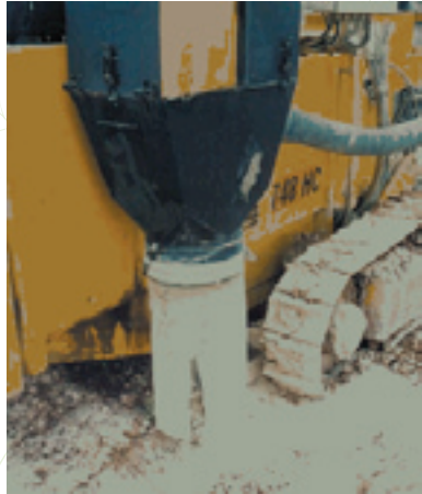
Ilustración 51 Perforación de barrenos con sistema de aspiración de polvo
