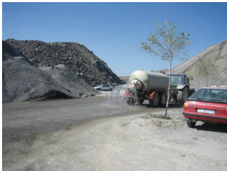
Ilustración 47 Riego de las pistas de acarreo
