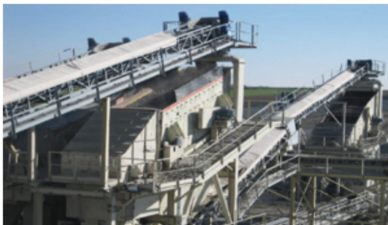
Ilustración 71 Cinta transportadora en funcionamiento
