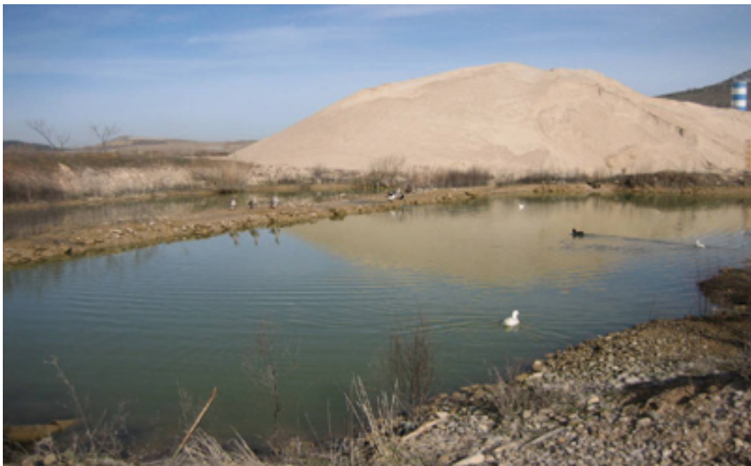
Ilustración 12 Balsa de decantación de lodos
