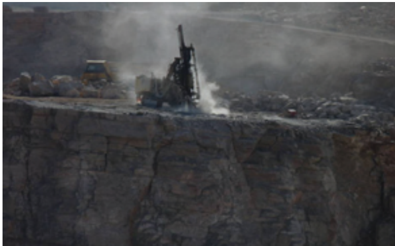
Ilustración 40 Perforadora en funcionamiento
