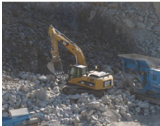
Ilustración 70 Retroexcavadora en funcionamiento
