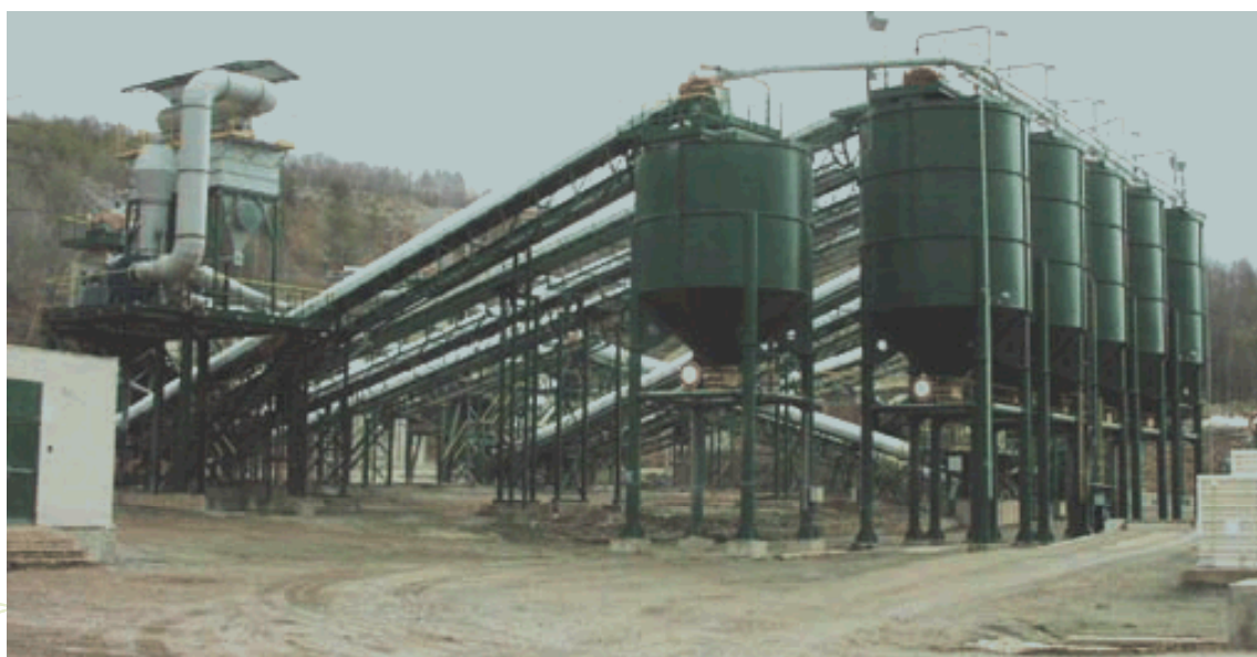
Ilustración 44 Cintas capotadas y almacenamiento en silos
