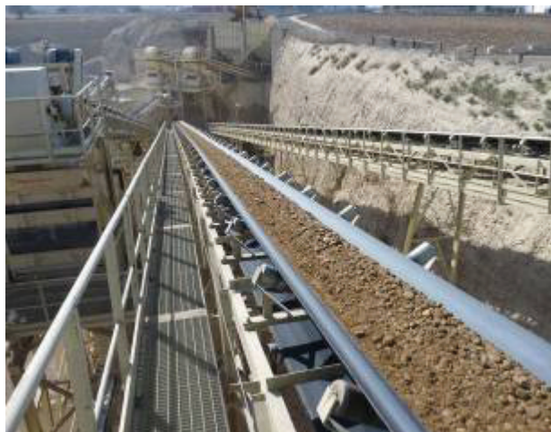
Ilustración 5 Cinta transportadora en funcionamiento
