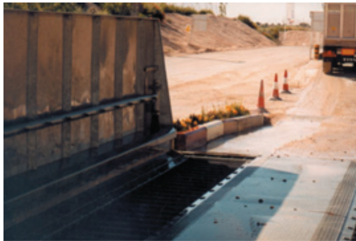
Ilustración 9 Lavado de camiones con arquetas de separación de hidrocarburos
