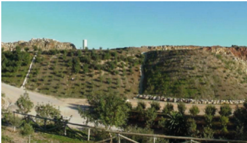
Ilustración 38 Restauración de acopios de estériles. Uso final forestal
