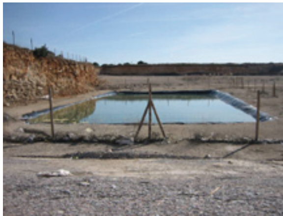
Ilustración 8 Balsa de decantación de lodos
