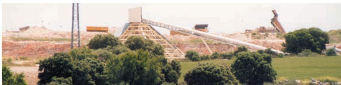
Ilustración 26 Vista explotación de áridos
