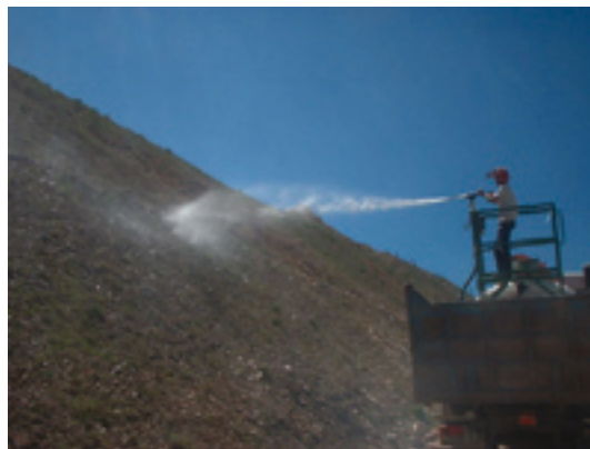
Ilustración 32: Hidrosiembra
