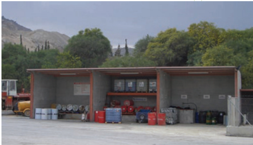
Ilustración 60 Zona de almacenaje de residuos peligrosos
