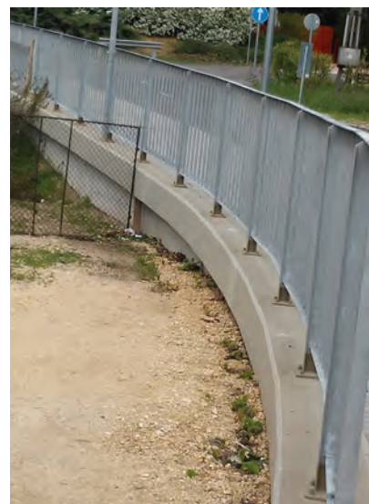
11. ábra A síkalapozású szögtámfal Balatonvilágosnál
