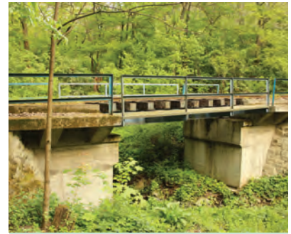
6. ábra. A Damásdi-patak hídja az 54+88 szelvényben (Fotó: Pokorny Bence)
