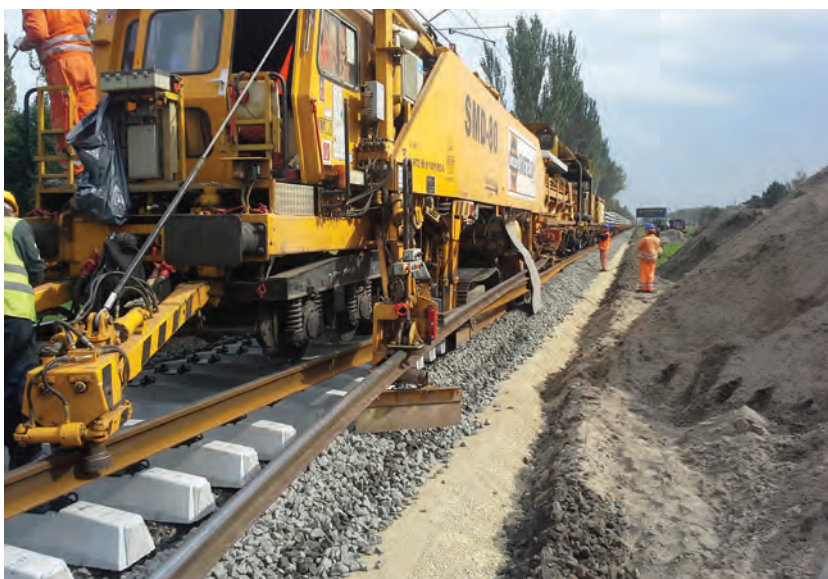
4. ábra. Munka közben az SMD 80 felépítményátépítő géplánc
