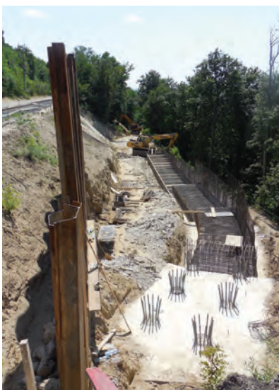
9. ábra. A balatonvilágosi gabionfal építés közben
