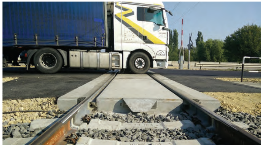
1. ábra. Szálerősített elemekkel kialakított vasúti átjáró
