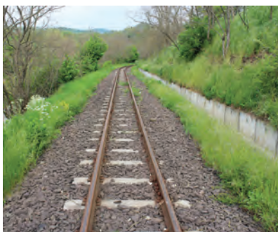
7. ábra. Előregyártott elemekkel burkolt árok Márianosztra alatt (Fotó: Pokorný Bence)
