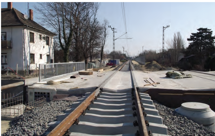
13. ábra. A vasúti híd pályalemeze Edilon felépítménnyel
