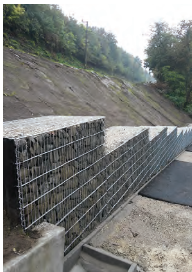
10. ábra. A kész gabion támfal a vasúti töltés lábánál
