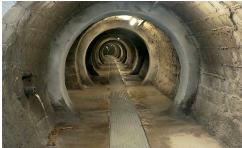
7. ábra. A felújított mélyszivargó táró
