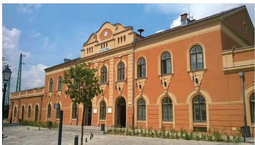
6. ábra. A felújított homlokzat – jelenlegi állapot
