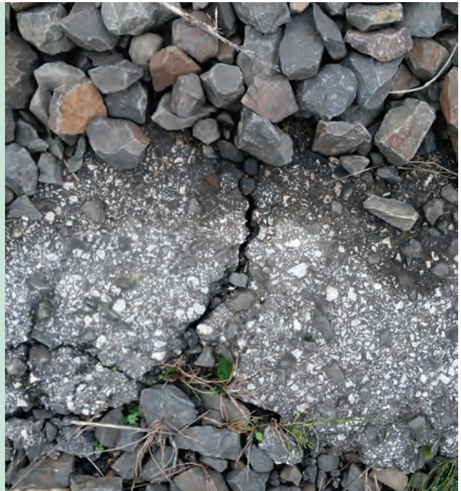
2. ábra. Vágánytengelyre merőleges repedés
