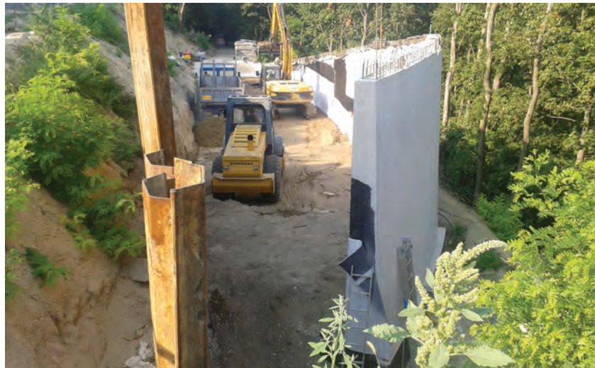
8. ábra. Cölöpalapozású szögtámfal építése Balatonvilágosnál
