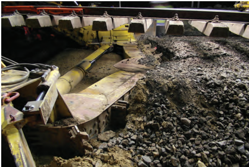
2. ábra. Meglévő anyagok kitermelése alépitmény-javító gépláncsal
