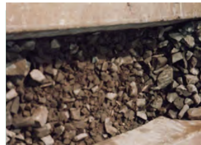
5. ábra. Az alj alsó síkja közelében jelentősen aprózódott zúzottkő ágyazat
