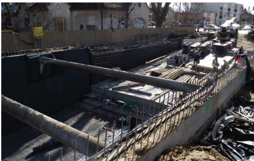
12. ábra. Siófokon a Vitorlás utcai aluljáró rámpás szakasza építés közben
