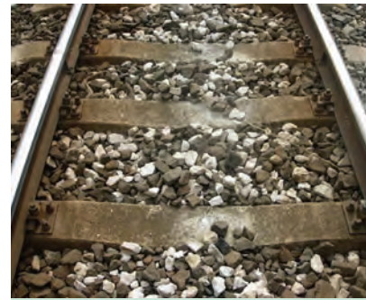
9. ábra. Vegyes kőzetanyagú, felújításra váró ágyzat
