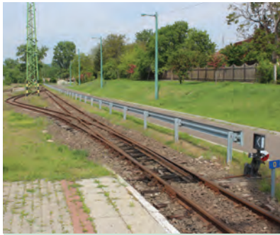
4. ábra. A szobi végállomás rövid vágányai (Fotó: Pokorny Bence)
