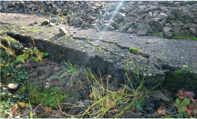
1. ábra. Az oldalsó letöredezettség
