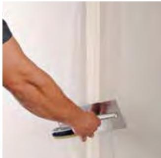
Bewehrungsstreifen glatt ziehen; Spachtelschicht abbinden lassen
