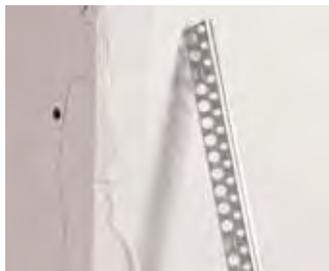
Fugenfüller auf Kante auftragen
