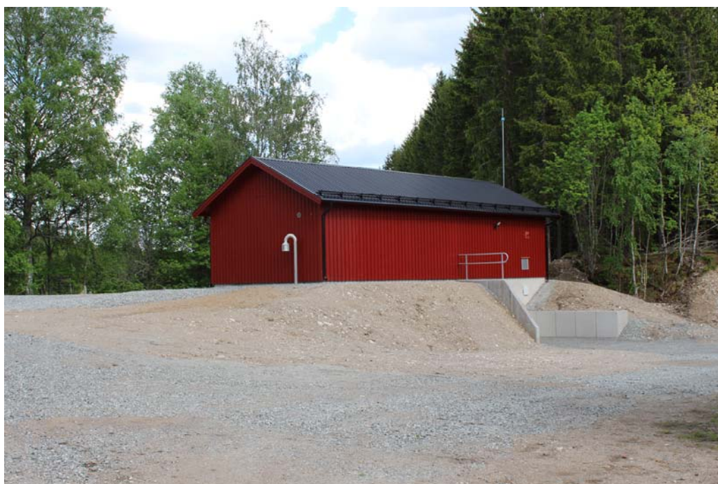
Vattenverket i Färna.
