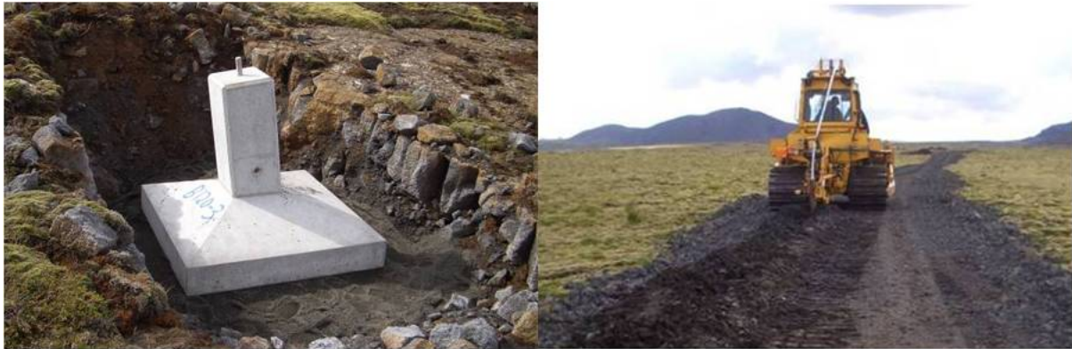
Mynd 2.37 Til vinstri má sjá forsteyppta undirstöðu M-masturs og hægri sést hvernig jarðskaut er plægt í vegslóð.
