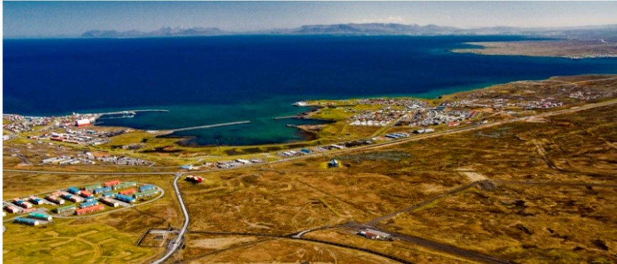
Mynd 3.4 Horft í norðausturátt að Fitjum í Njarðvík. Tengivirkið fyrir miðju.
