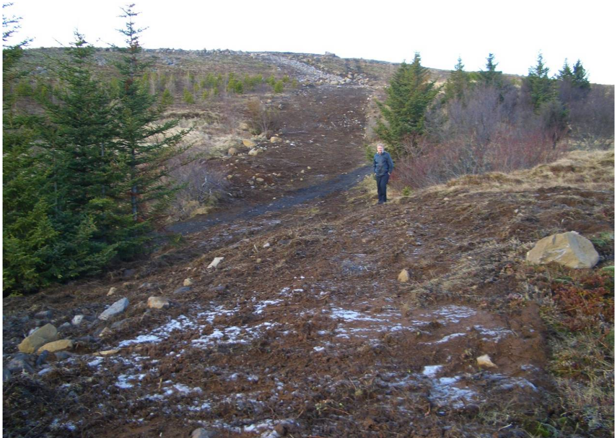
Mynd 2.4 Rask við Rauðavatn eftir lagningu 132 kV jarðstrengs
