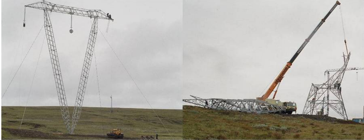
Mynd 2.39 Myndin til vinstri sýnir hvar upphengibúnaði er komið fyrir og myndin til hægri sýnir reisingu frístandandi masturs.
