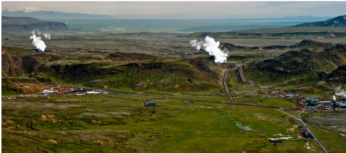
Mynd 4.29 Horft til austurs. Sjá má Hellisskarð þar sem lagnir liggja að Hellisheiðarvirkjun. Tengivirki við Kolviðarhól er fyrir miðri mynd.
