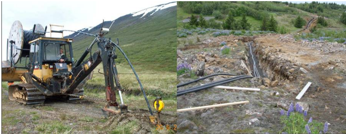
Mynd 2.2 Til vinstri má sjá 11 kV streng í dreifikerfi plægðan niður og til hægri sést skurður fyrir 132 kV streng í flutningskerfi.
