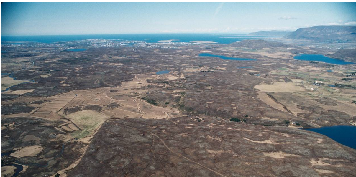
Mynd 4.32 Myndin sýnir útsýni yfir tengivirkið við Geitháls til vesturs. Hægra megin á myndinni má sjá Selvatn og afrennsli þess í Elliðakotsmýrar, sem eru fyrir miðri mynd. Myndin er tekin vorið 2006.
