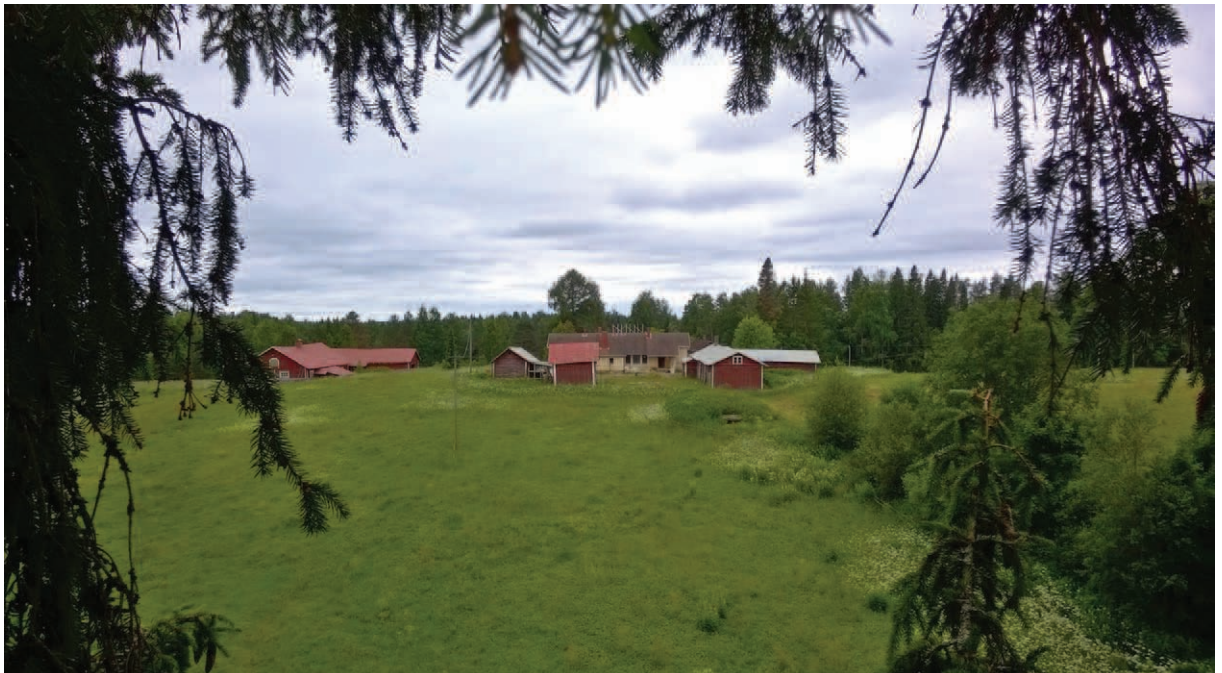
Tilan rakennuksissa riittää kunnostamista. Kuva Risto Sulkava
