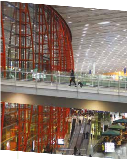
Aeropuerto Internacional de Beijing, China
