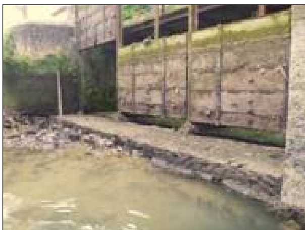
Vues des vannes de l'ouvrage Leullieux
