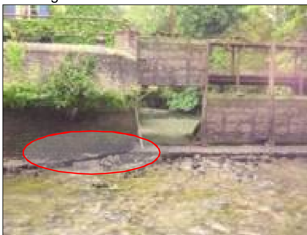
Reprise des fondations du mur
