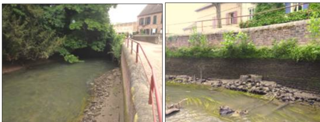
Vue amont entre les deux ouvrages avec Arjo Wiggins en position vannes ouvertes
