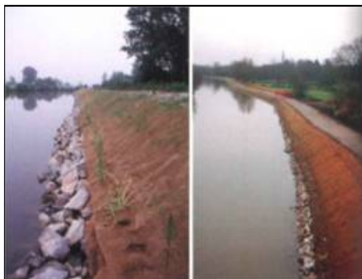
exemple de travaux
