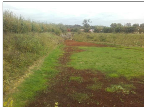
Bassin de rétention situé entre « le Royon » et le Long Près » (proche RD158)
