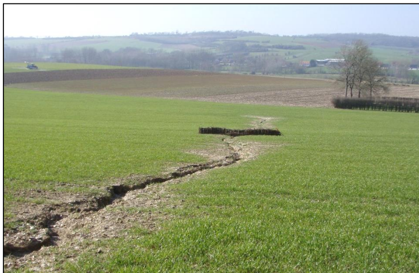
Ouvrage Fascine – Fauquembergues (2011)
