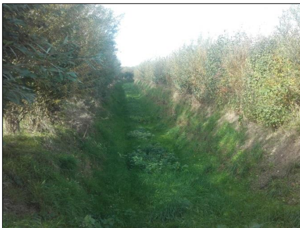
Fossé d'infiltration situé le long du chemin d'exploitation au lieu-dit « le Vaucher »
