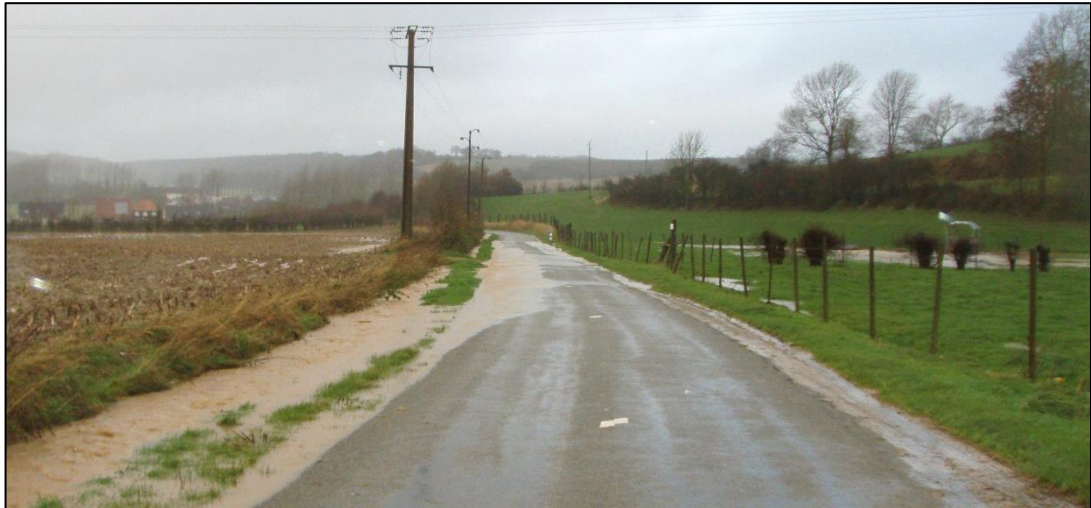
Ruissellement sur la RD 129E3 à Renty (Assonval – 2009)
