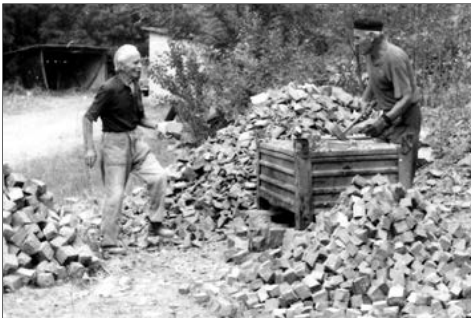
Obr. 10. Výroba dlažobných kociek v kameňolome Ragáč v roku 1992. Foto: E. Gaál Fig. 10. Production of basalt pavement cubes in the quarry Ragáč in 1992. Photo: E. Gaál
