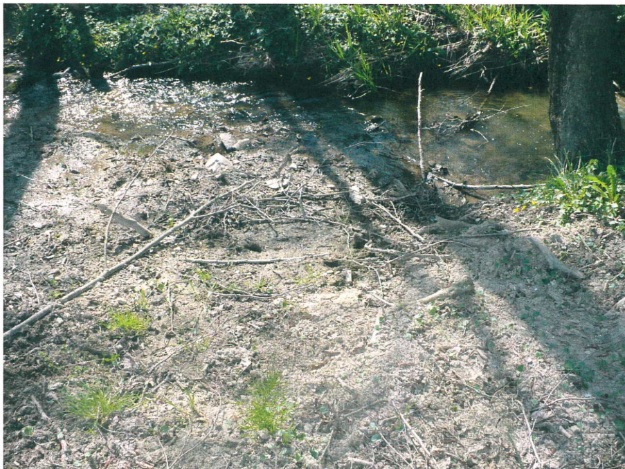
Viehtränke durch Einzäunen des Ufers am Kaltenbach in Jößnitz (LRA Vogtlandkreis, 2010)
