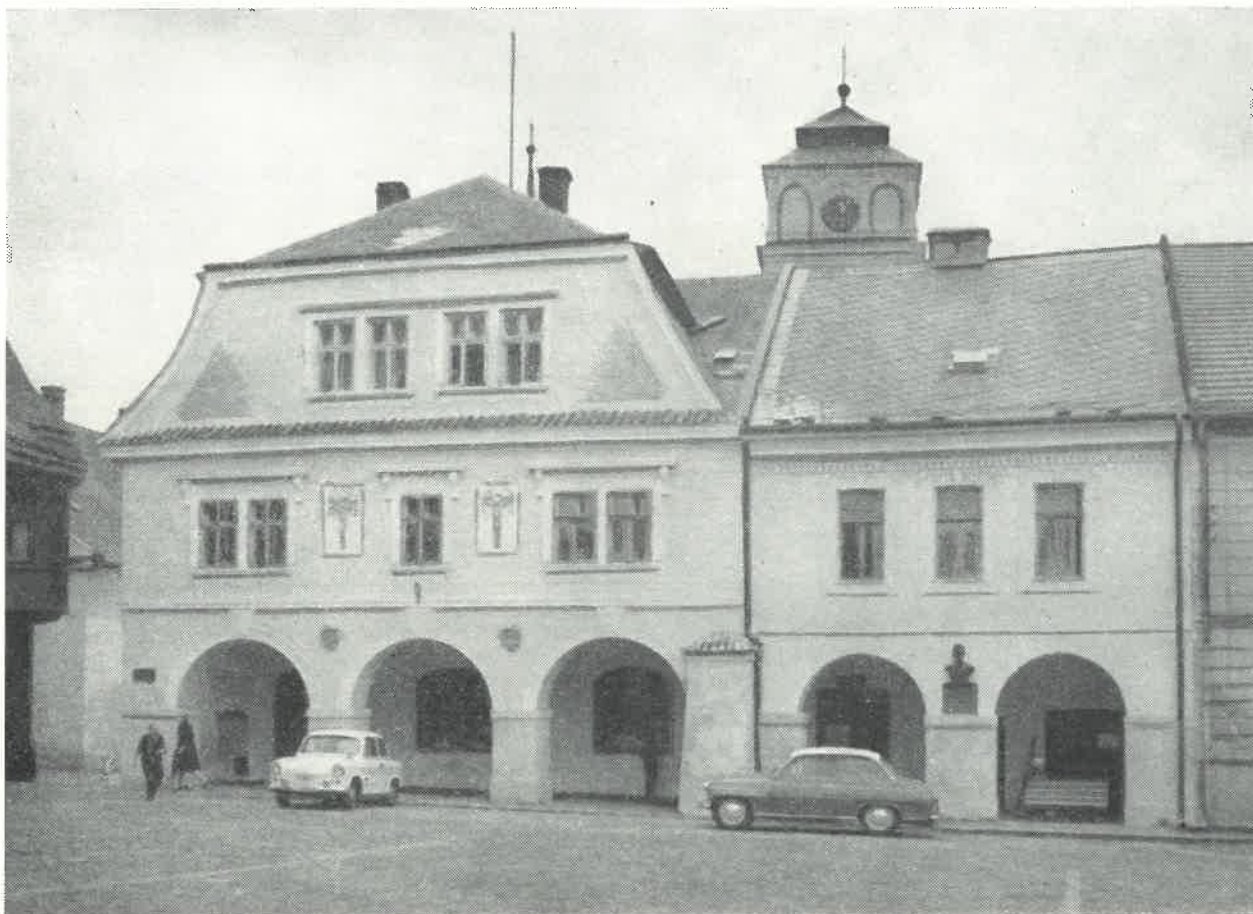
Opravený Šrámkův dům v Sobotce. Vpravo rodný dům básníků
