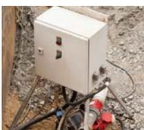
In Verteilerkästen werden Reiheneinbaugeräte, wie Leitungsschutzschalter, Fehlerstromschutzschalter, Fern- und Zeitschalter u.s.w. untergebracht. Von dem Unterverteiler werden dann die einzelnen Leitungen in die Räume geführt.
