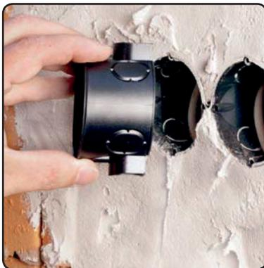
Die Leitungsverlegung unter Putz und die Montage der Schalter- und Abzweigdosen erfolgt nach der Fertigstellung des Rohbaus vor Beginn der Putzarbeiten.
