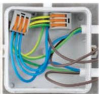
Die schraubenlosen Steckklemmen eignen sich für eine schnelle und berührungsgeschützte Verbindung von Leitern.
