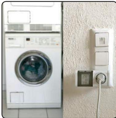
Mit dem Energiekostenmessgerät 45731 kann der Stromverbrauch einzelner Geräte gemessen werden.
