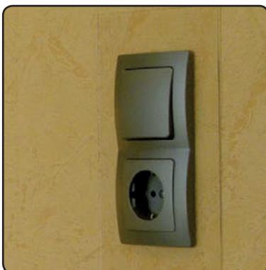
Schalter und Steckdosen werden bei der Unterputzinstallation mit Spreizkrallen (bei Unterputz-Schalterdosen), oder mit Geräteschrauben (bei Hohlwand-Schalterdosen) in den Schalterdosen befestigt.
