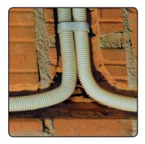
Neuinstallationen in Wohnräumen werden als Unterputzinstallation ausgeführt. Die Leitungsverlegung ist nach der Installation durch den Putz oder Tapete nicht mehr sichtbar.
