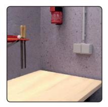
Schalter und Steckdosen für die Feuchtraum-Installation werden in der Schutzart IP44 oder IP54 (spritzwassergeschützt) hergestellt.
