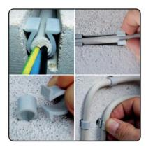
Eine einfache Befestigung von Leitungen ohne Nageln bietet die Mauernutschelle in gefrästen Schlitzen oder direkt auf dem Mauerwerk.
