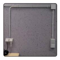
Bei der Aufputzinstallation werden Kabel, Leitungen und Rohre wegen der einfachen Montage direkt auf dem Putz oder mit Abstandsschellen über dem Putz verlegt.
