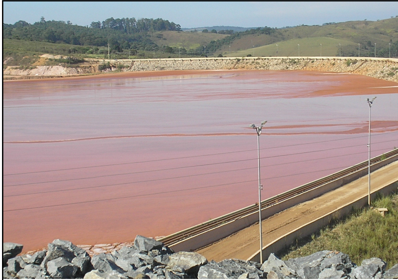
Barragem de Lama Vermelha - CBA - Alumínio-SP
