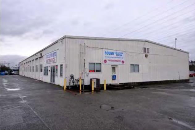
720 Rainier Ave S_Bldg 2__2020_NE.JPG
