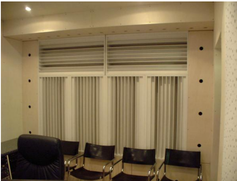
Abb. 69: Rückwand (Live-End) eines Tonstudio-Abhörraums mit NWDs [VATTER, 2011]
