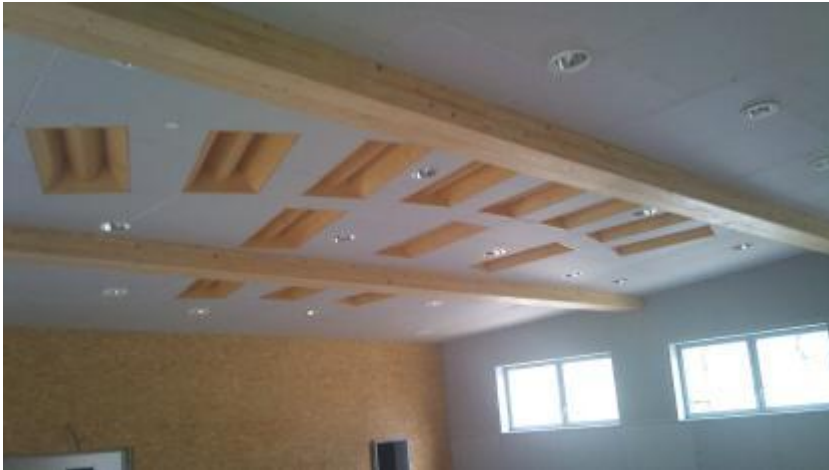
Abb. 72: Deckenspiegel mit Parabolic Wave Diffusoren [VATTER, 2011]
