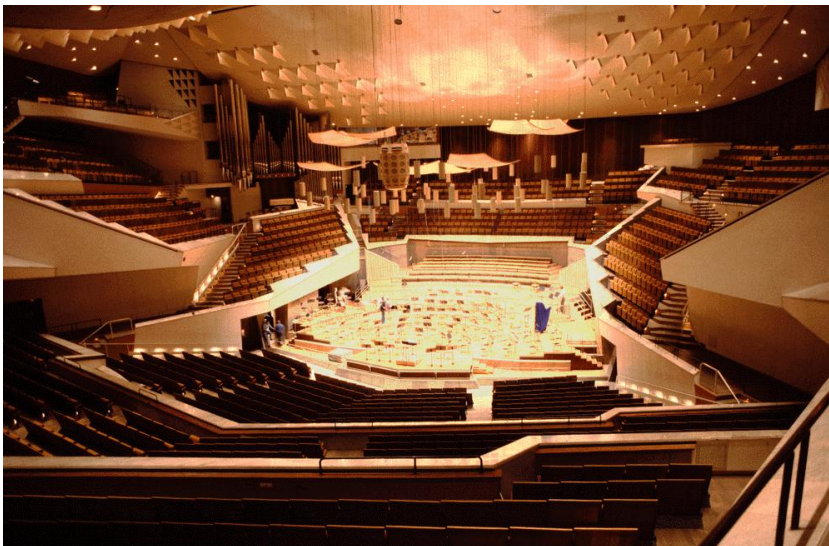
Abb. 67: Deckenakustiksegel im Hauptsaal der Berliner Philharmonie [ www.wordpress.com , 2011]
