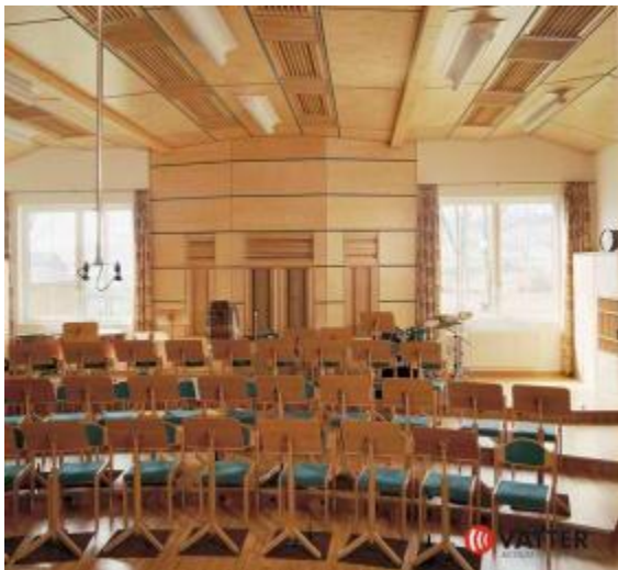
Abb. 70: Akustikdecke mit Numeric Wave Diffusoren [VATTER, 2011]
