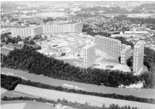
Abbildung 5: Die 1 km lange Wohnzeile von Le Lignon entsteht, Vernier, Genève, Juli 1969
