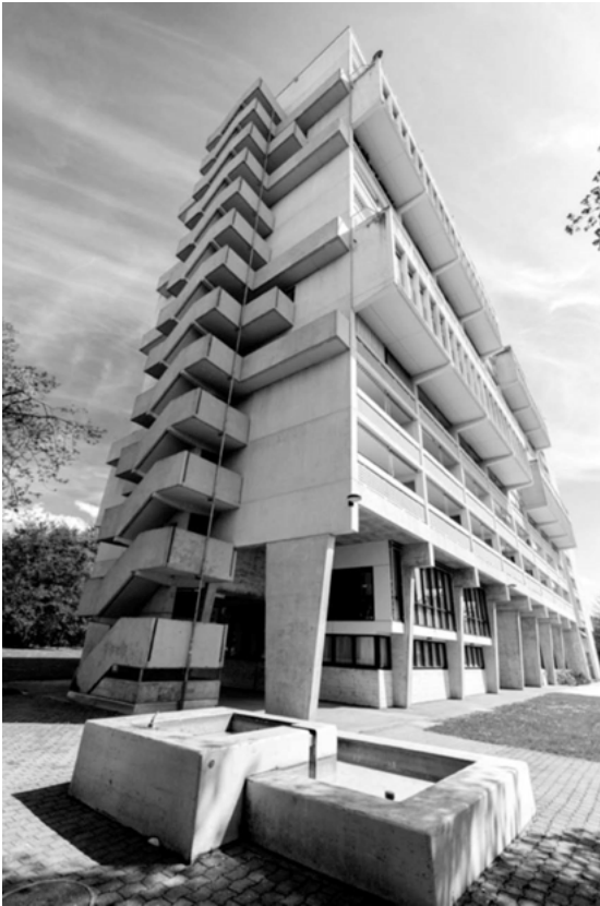
Abbildungen 36 und 37: Hauseingang auf Stützen
