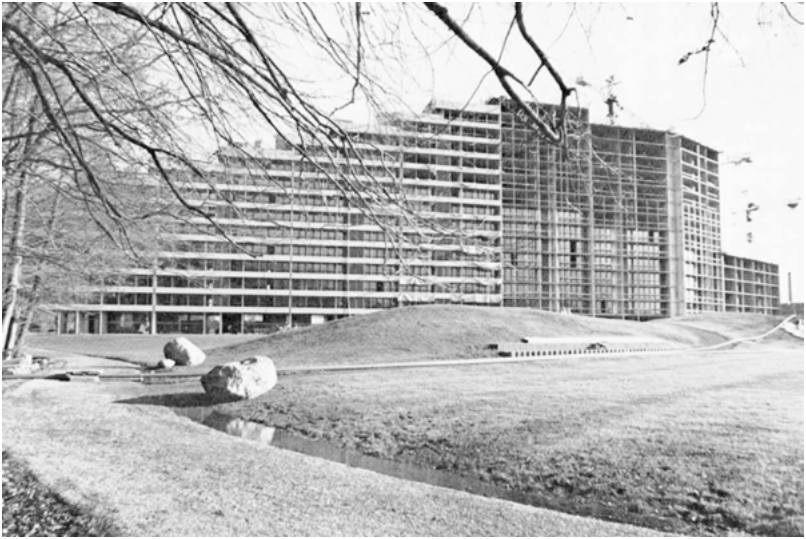
Abbildung 75: Wohnzeile A im Bau, 1972
