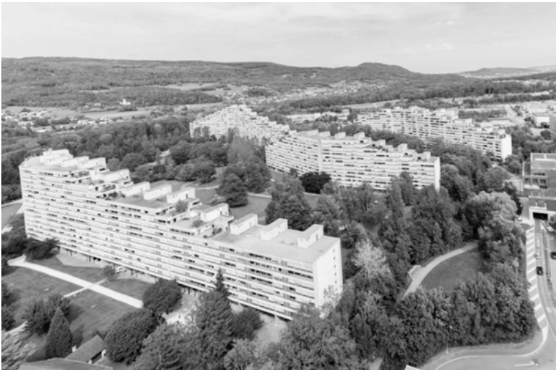
Abbildung 78: Blick auf die heutige Tellisiedlung
