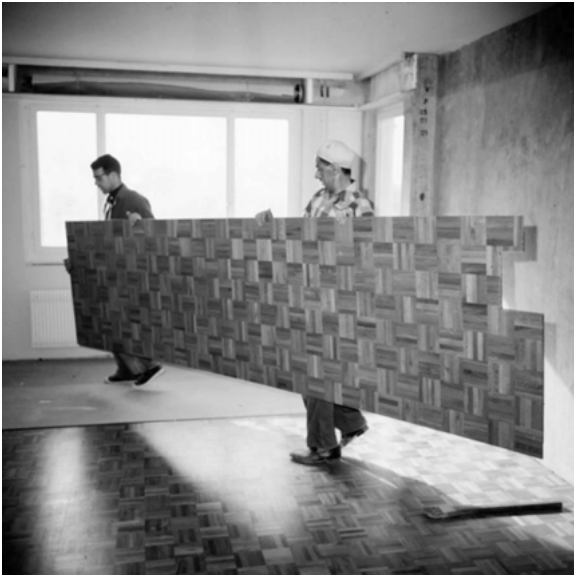
Abbildung 8: System Göhner, vorgefertigter Bodenbelag, September 1966
