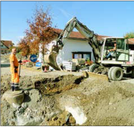
Jüngst - umfassende Sanierungsarbeiten
