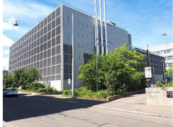
Abbildung 3 ewz-Energiezentrale Flüelastrasse 28 (Foto: Mai 2020)
