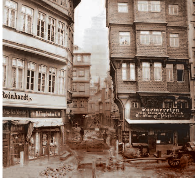
Kanalarbeiten am Alten Markt (1872, links) und in der Judengasse (1884)
