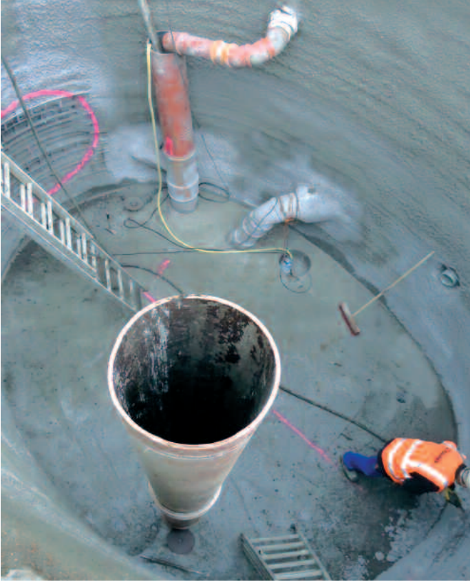
Oben links: Schachtbaugrube mit Spritzbeton-Verbau und Fremdleitungen
