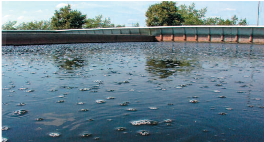
Rechts: Im mehrschichtigen Filterbett der Denitrifikation wird Nitrat in Stickstoff umgewandelt, der in feinen Blasen ausgast.
