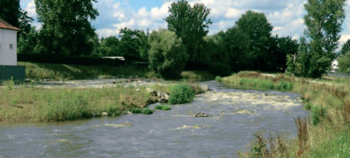
Oben: Der Umbau des Hächster Wehrs in den Jahren 2012 und 2013 war ein Meilenstein auf dem Weg zu einer naturnahen Nidda. Durch ein ca. 100 m langes Umgehungsgerinne können Fische das Wehr nun auch wieder gegen die Fließrichtung passieren.
