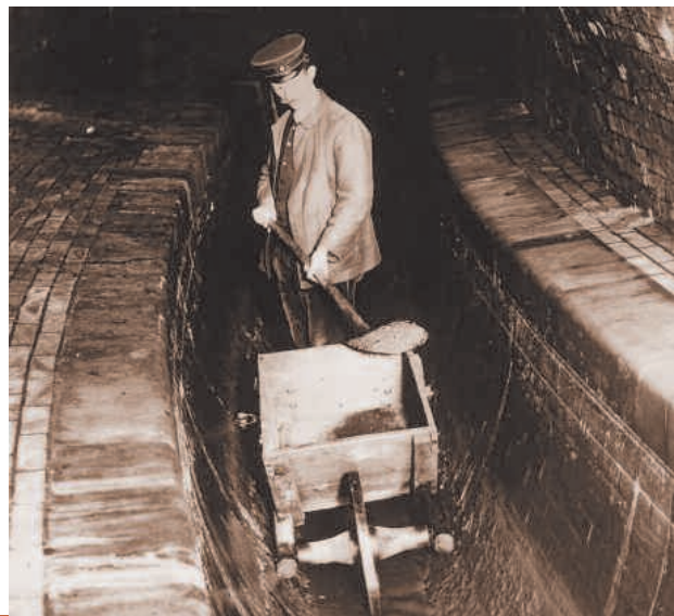
Alles Handarbeit... Kanalreinigung mit Wurzelbürste und Sandwagen um 1900
