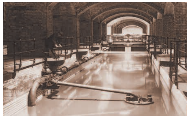
Erste Schritte zur Mechanisierung: die Flügelrechenanlage, eine Konstruktion Frankfurter Techniker (links) und das Saug- und Druckleitungssystem mit Schwimmschlamm-sauger (rechts)
