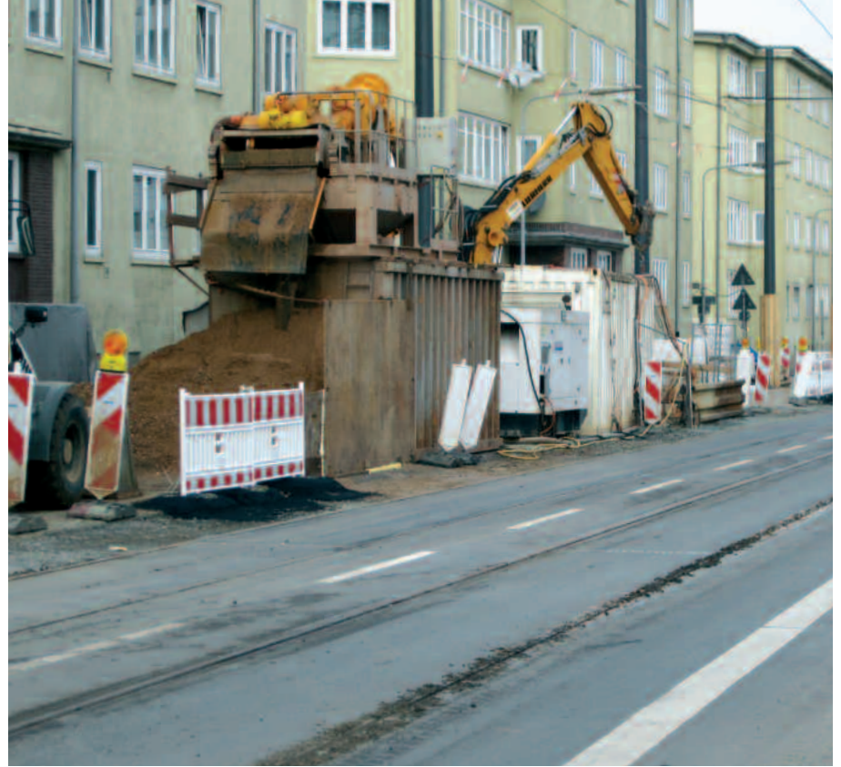
Oben links: Auffüllen eines Kanalgrabens nach der Rohrverlegung mit Flüssigboden
