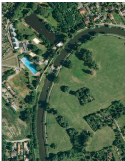
Rechts: In den Luftbildern wird das Ausmaß der Veränderung deutlich. Im rechten Bild (nach dem Umbau aufgenommen) sind das Umgehungsgerinne, das Wehr und die dazwischen neu entstandene Insel gut zu erkennen. Unterhalb des Wehrs wurde der Uferweg zurückverlegt. Dort entwickelt sich ein Überflutungsbereich mit Stillgewässern und Gehölzgruppen.
