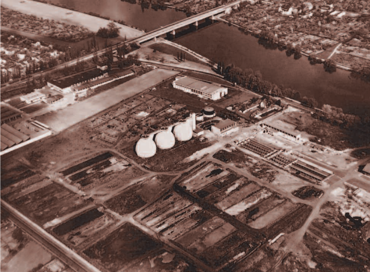
Luftbild der im Betrieb und Bau befindlichen Klärvorrichtungen mit Faultürmen (Bildmitte)
