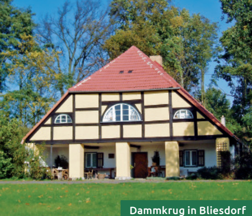
Dammkrug in Bliesdorf Amt Barnim-Oderbruch
