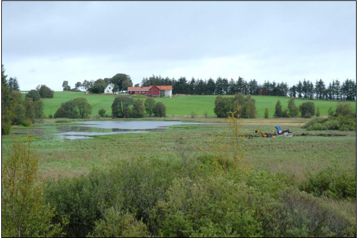
Graving av mindre dammar i sørenden for å skape ein større våtmarksmosaikk.
