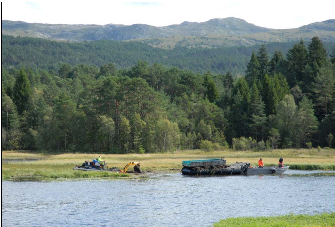
Arbeid tidleg i prosjektet.
