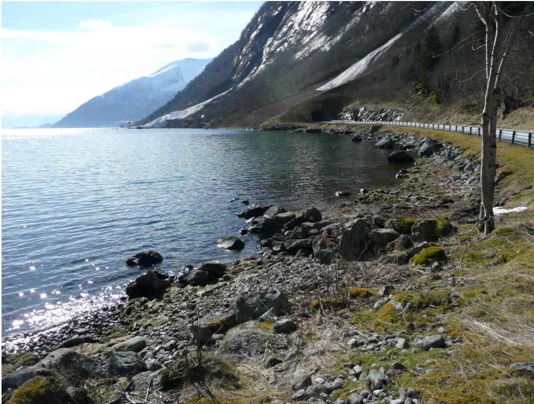
Fylkesveg 5 og vegfylling mot sjøen i grensa for naturreservatet, sett mot sør. Foto: Tom Dybwad
