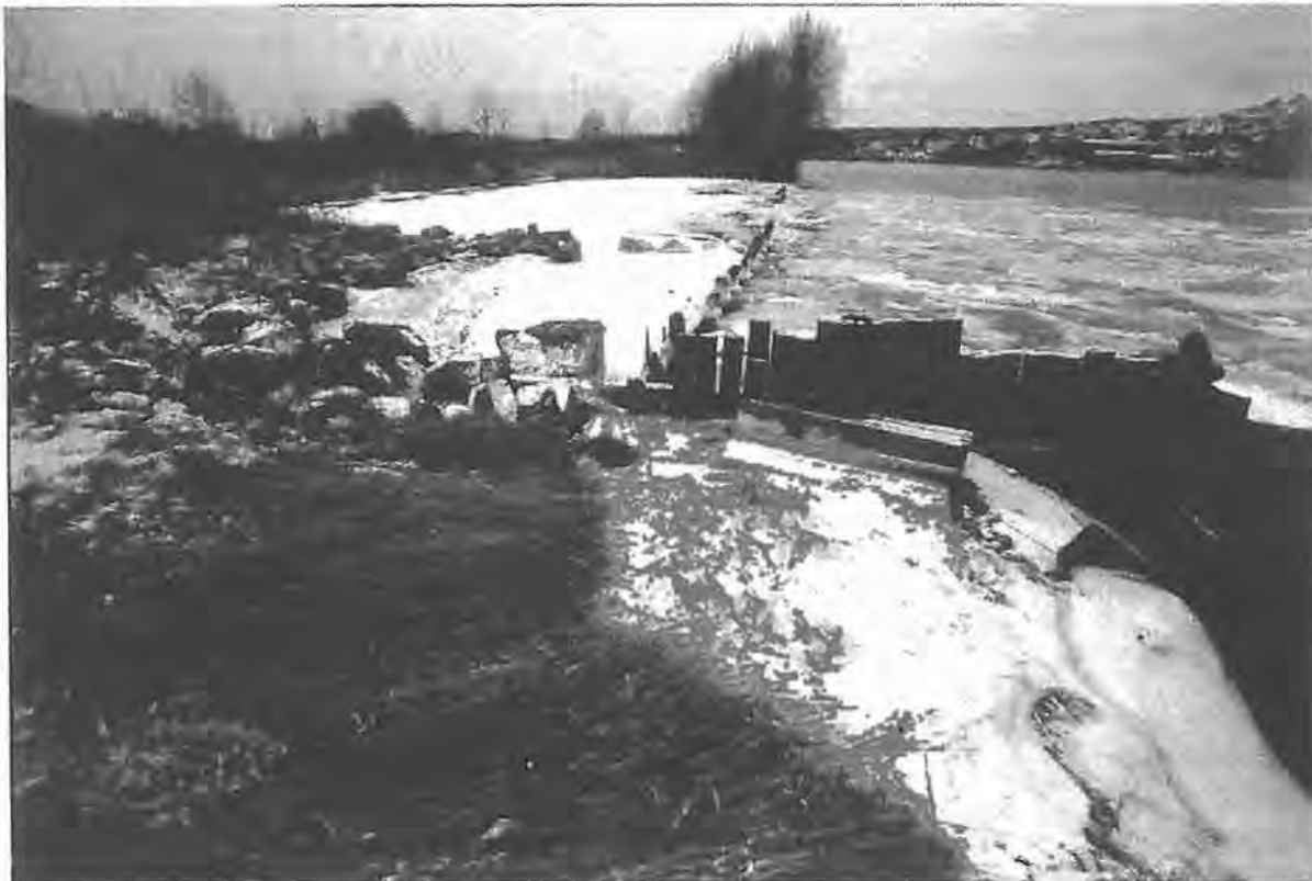
Mot elva ses fortsatt en del av de gamle ballastskjermer som skulle holde på ballastjorda. Deler av skjermen er av stål og er nok kommet til i ny tid da de opprinnelige var av stikkverk. (Foto: Forf. 5. feb. 2001)
