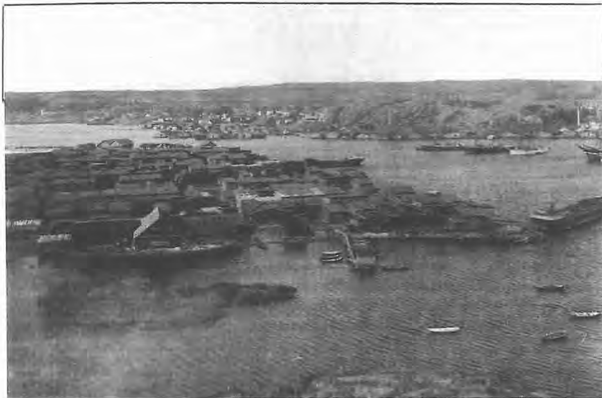
Bildet viser Røds Brugs mange trelastlagre bygd opp som en halvøy av ballastjord utenfor selve sagbruket. Onsøylandet ses i bakgrunnen, ca 1880. (Bildet utlånt av S. Skahjem.)
