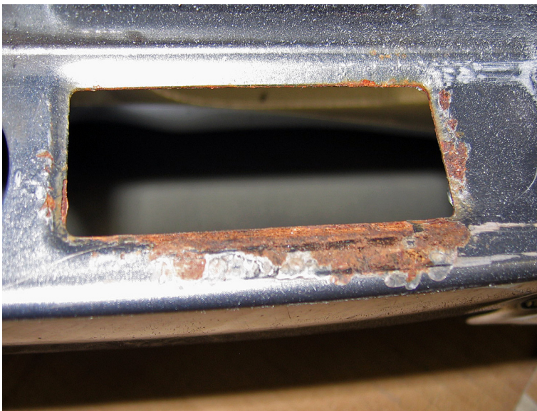
Bild 9-010 Ausschnitt Kennzeichenleuchte. Ursache ist: 1. Kantenflucht 2. Unterbeschichtung und ungenügende Hohlraumkonservierung 3. Zu Enge Passung, dadurch Lackabrieb oder -abplatzung
