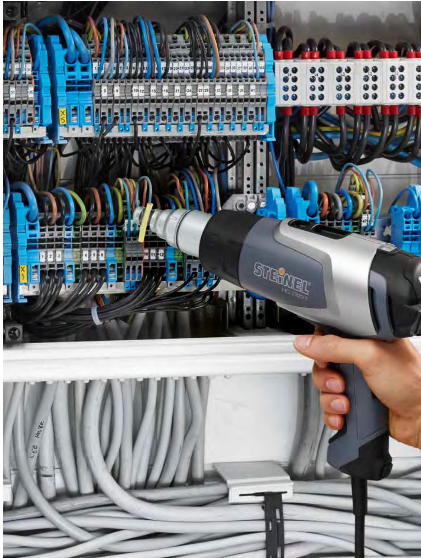
Kabel schrumpfen im Verteilerschrank.
