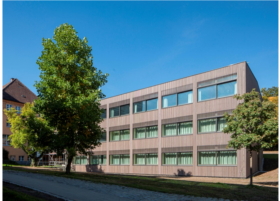
Aufstockung Lehrsaalgebäude (Foto: M.H.)
