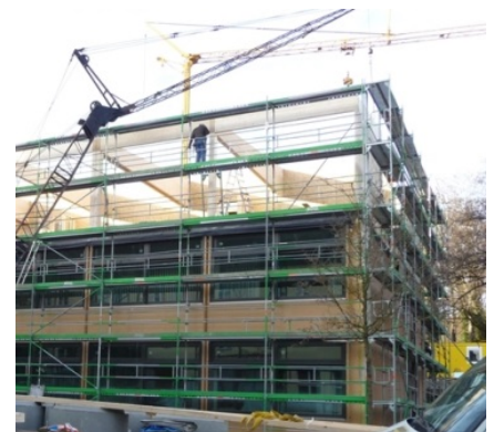
Aufstockung Lehrsaalgebäude (Foto: BA.)
