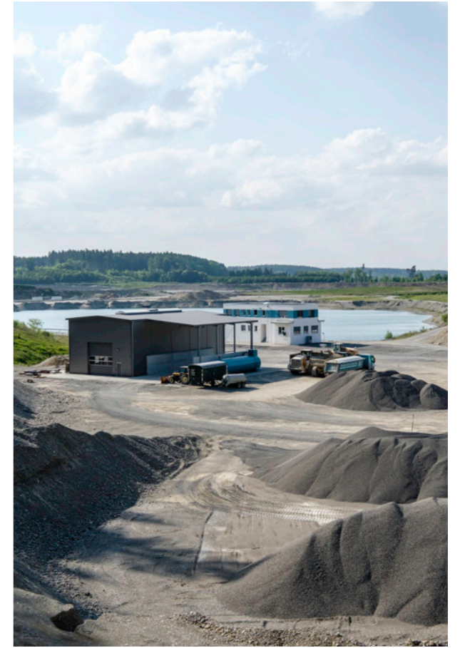
Sicht auf Werkhalle mit Tank- und Waschhalle (vorne) und Verwaltung (hinten).
