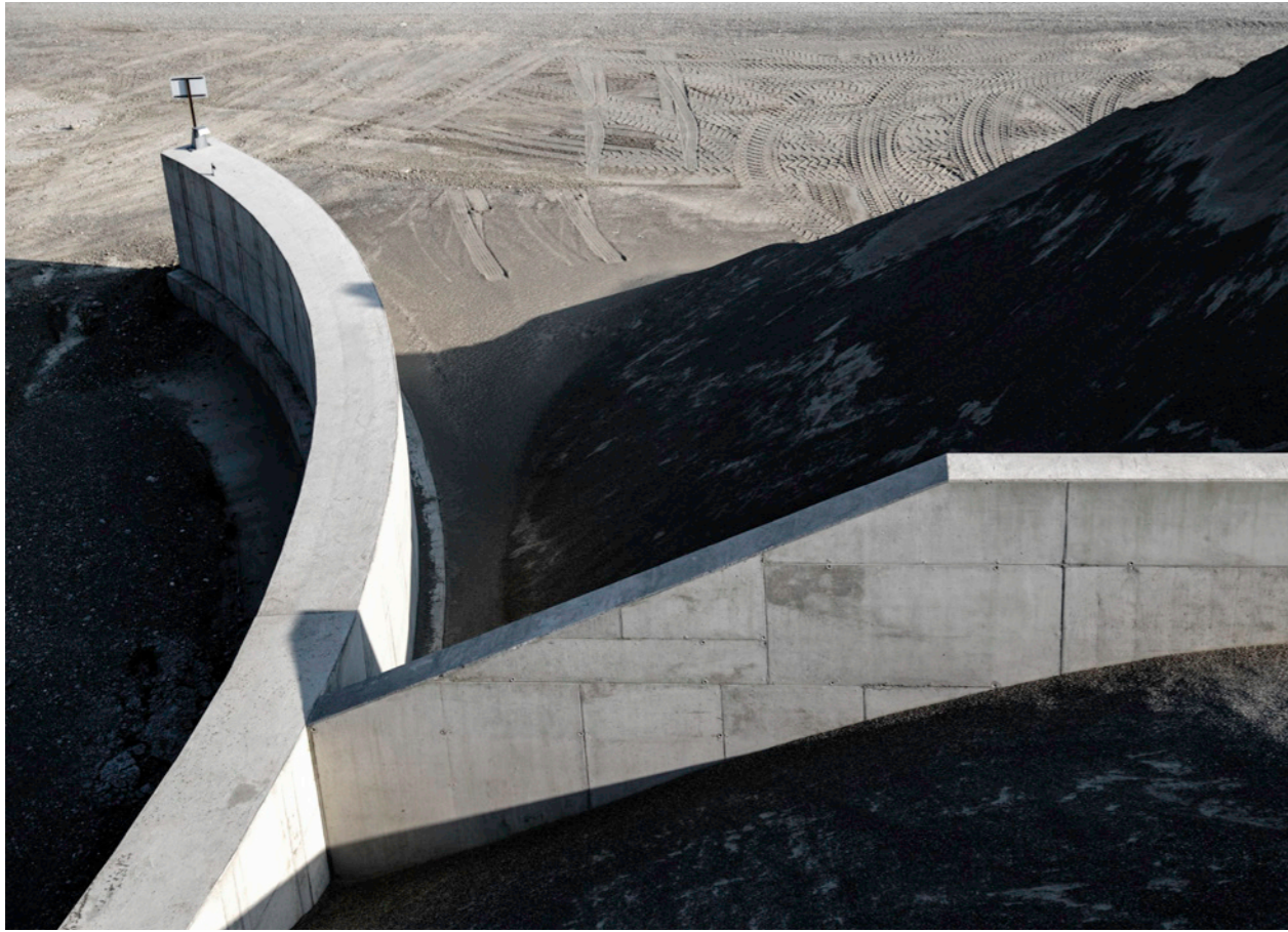
Silobauwerk für die getrennte Lagerung der verschiedenen Kies-Körnungen.
