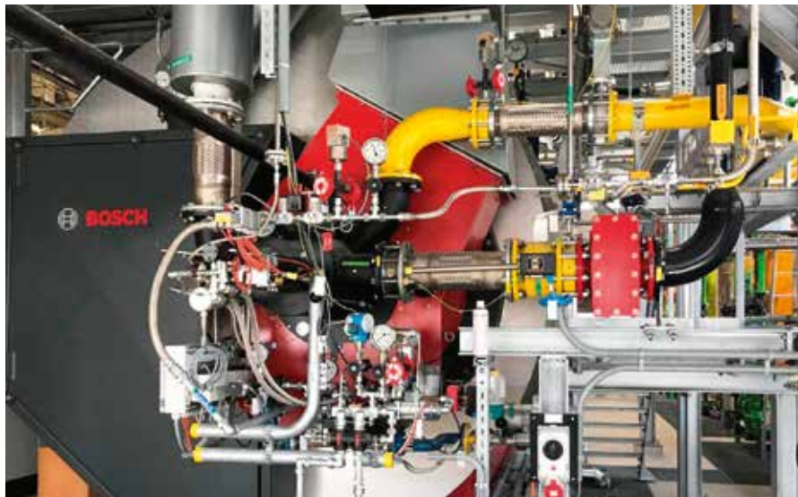
Bosch UL-S 20000: combineert klassieke brandstoffen aardgas en stookolie met waterstof
