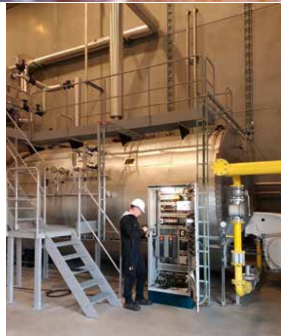
Klassieke gasgestookte stoomketel 10 T/u. (Foto Deconinck-Wanson)
