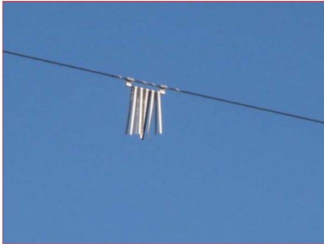
Abbildung 6: Erdseilmarkierung gegen Vogelschlag
