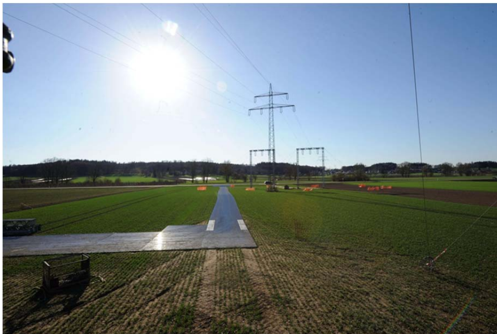
Abbildung 9: Provisorische Zuwegung als Plattenzufahrt
