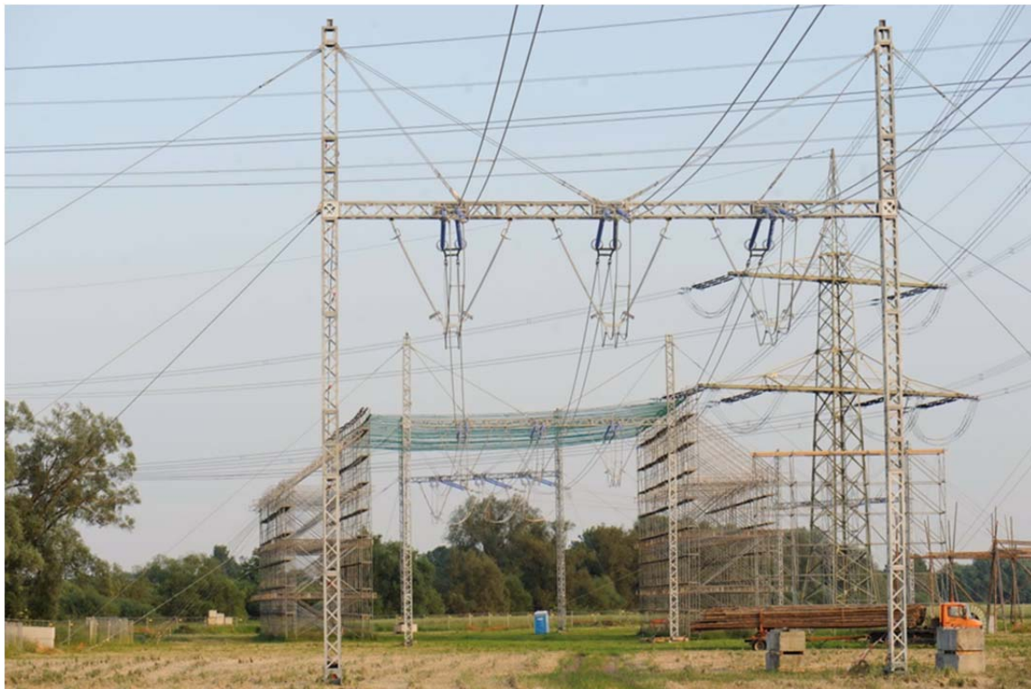
Abbildung 13: 380-kV Freileitungs-Provisorium für ein System, mit errichtetem Schutzgerüst
