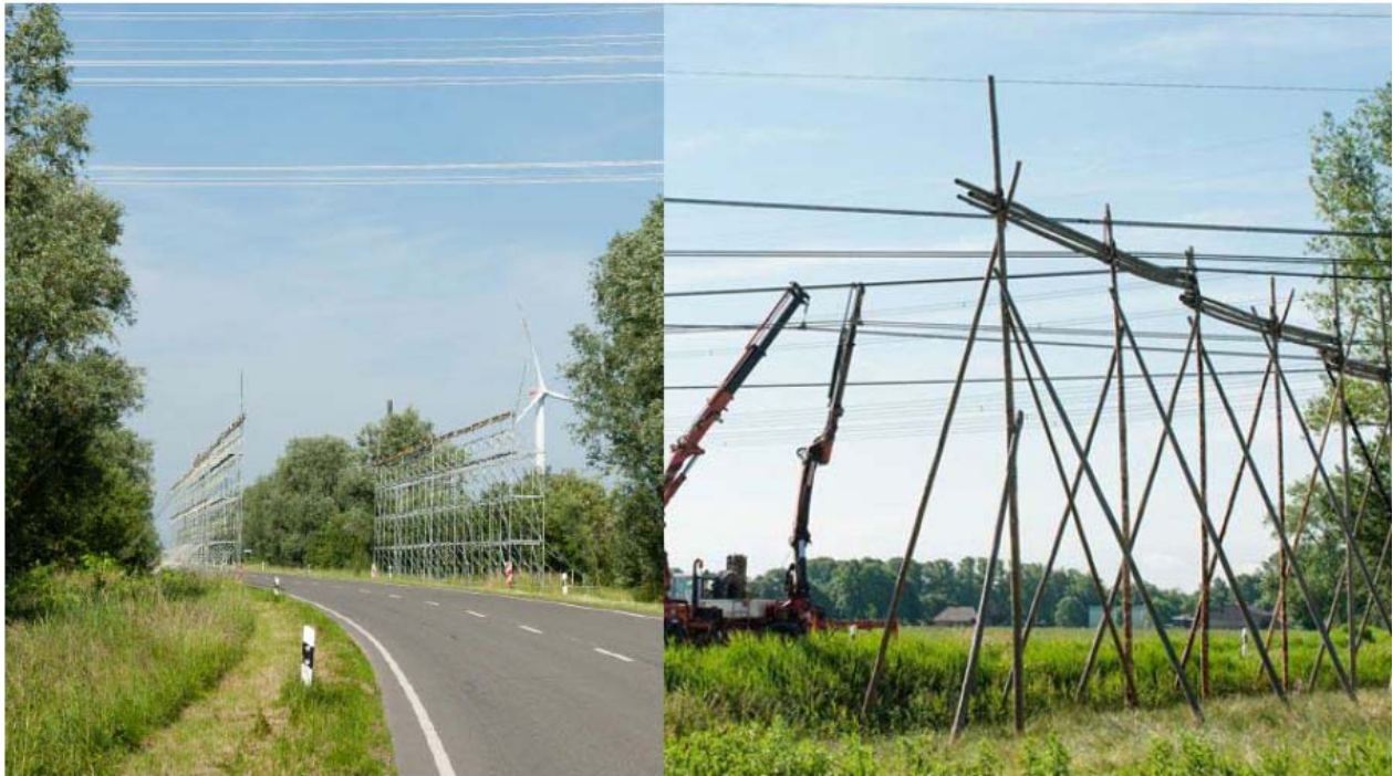
Abbildung 14: Beispiele für Schutzgerüste aus Stahl bzw. Holz
