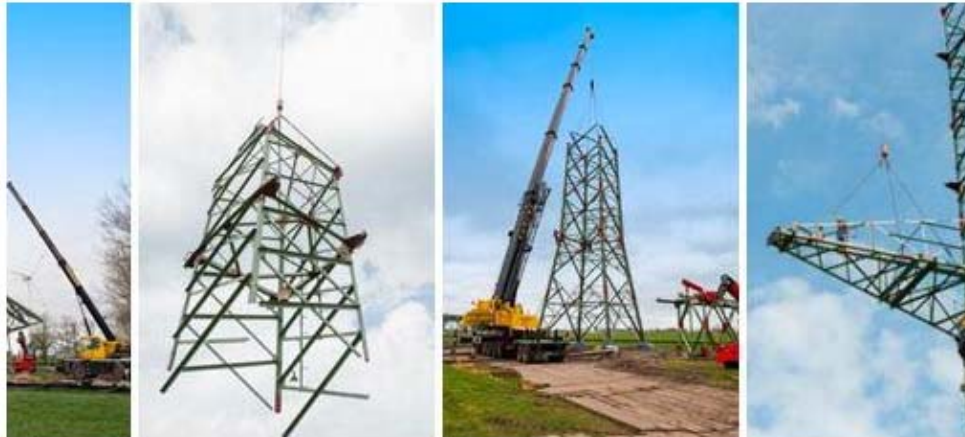
Abbildung 11: Stocken eines Freileitungsmastes
