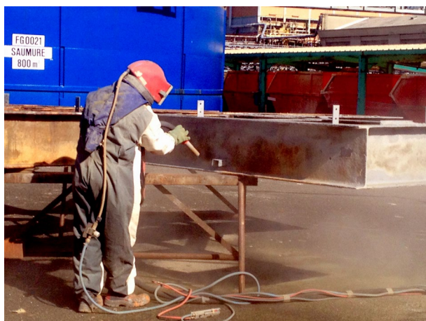
Photo 30 : Décapage à sec ; atelier et matériel © Prezioso Linjbygg
