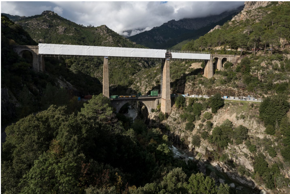
Photo 11 : Pont du Vecchio vue d'ensemble pendant travaux © Lassarat
