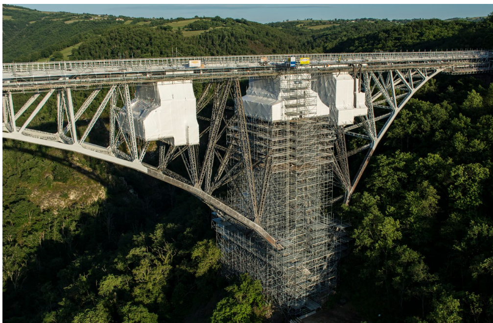
Photo 18 : Viaduc du Viaur en cours de travaux ; il est important de noter la juste répartition des échafaudages et confinements de chaque côté de la pile afin de respecter les charges admissibles et l'équilibre de l'ouvrage en phase travaux © Lassarat
