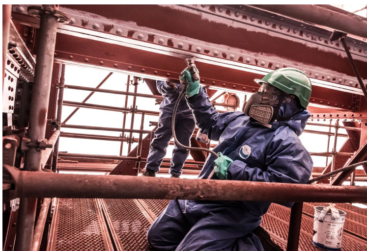
Photo 39 : Vue de l'application au pistolet sans air de la couche de primaire © Lassarat
