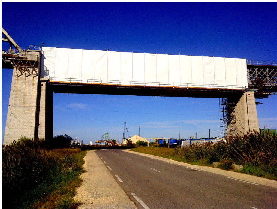
Photo 10 : Pont SNCF de Caronte, vue échafaudage et confinement © Lassarat
