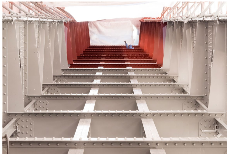
Photo 8 : Vue de la travée d'un pont métallique après application de la deuxième couche de primaire époxydique ©Lassarat
