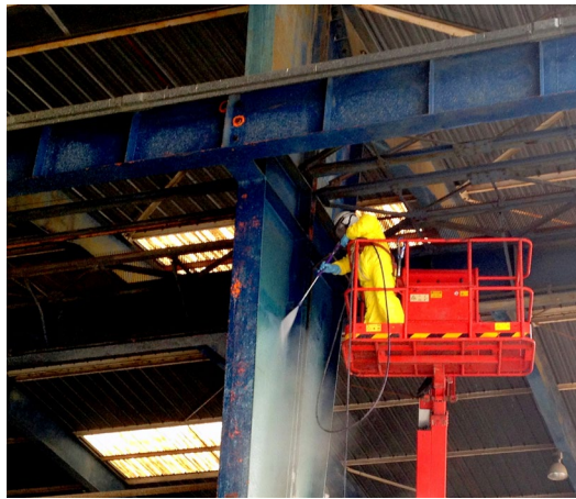
Photo 31 : Décapage à l'eau © Prezioso Linjebbygg
