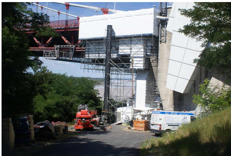
Photo 36 : Pont d'Aquitaine confinement © Prezioso Linjebygg
