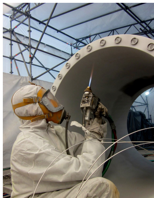
Photo 6 : Métallisation à la flamme © Lassarat
