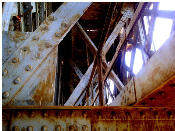
Photo 2 : Viaduc ferroviaire de Carante, travaux de réfection de la protection anticorrosion © Lassarat
