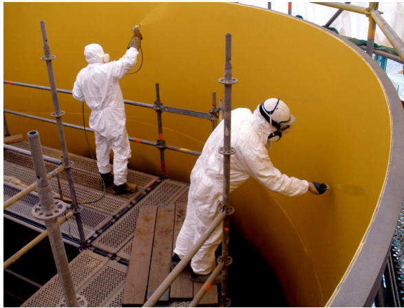
Photo 33 : poste peinture airless © Prezioso Linjebygg
