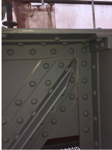
Photo 34 : Pont du Vecchio, vue du masticage des zones présentant des interstices entre fers © Lassarat
