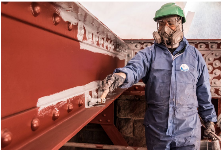
Photo 38 : Pont du Vecchio, vue montrant le travail de pré-touche, à la brosse, des zones difficiles d'accès au pistolet sans air et présentant des singularités © Lassarat
