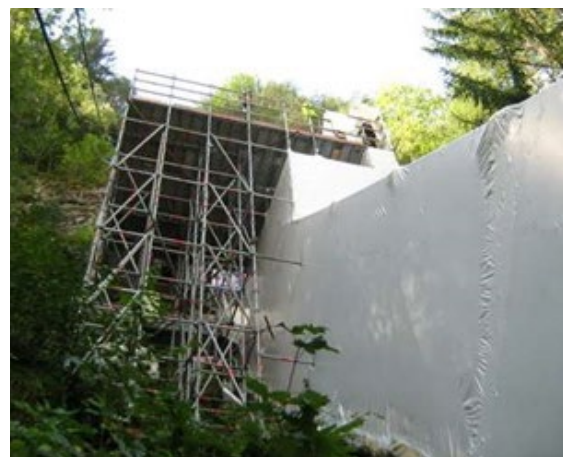
Photo 24 : Confinement - Réhabilitation CF
