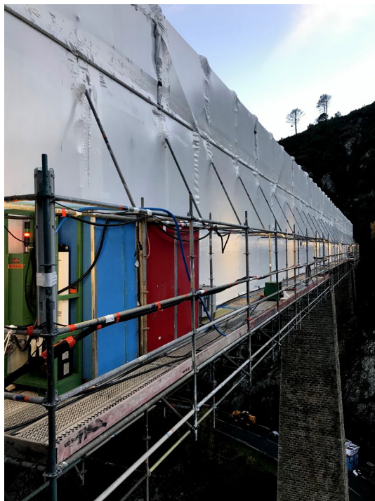
Photo 37 : Pont du Vecchio, vue du confinement et des sas permettant l'accès à la zone de travail © Lassarat
