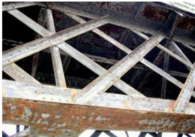
Photo 12 : Pont de Tulle avant travaux ©JP Persy
