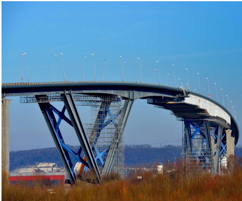
Photo 17 : Viaduc du grand canal du Havre en cours de travaux © Lassarat
