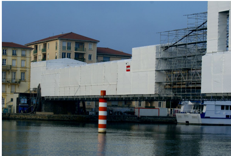
Photo 26 : Passerelle Sainte Colombe - Vienne © Prezioso Linjebbygg
