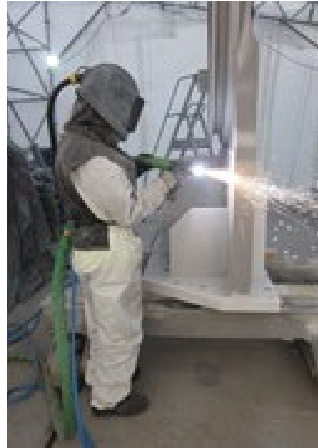
Photo 7 : Métallisation à l'arc électrique © Lassarat
