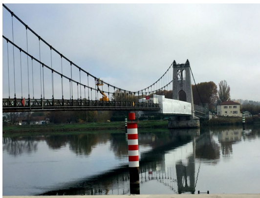
Photo 28 : Pont suspendu de La Voulte en cours de travaux © Lassarat
