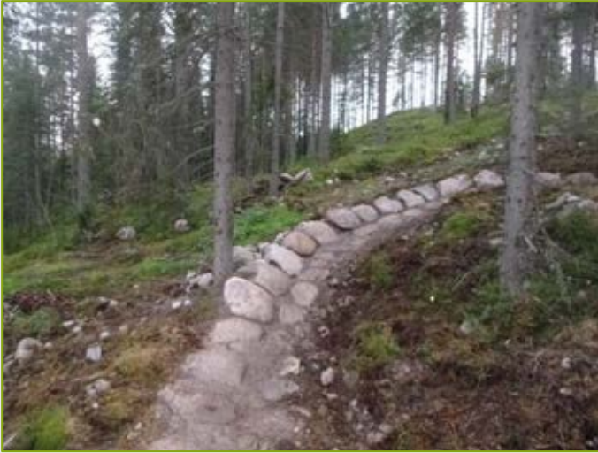
Abbildung 140: Steile Kurve mit Erosionsschutz
