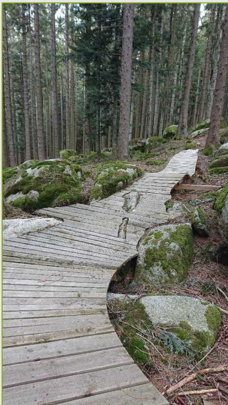
Abbildung 141: Einpassung eines Bohlenwegs in eine Felsformation
