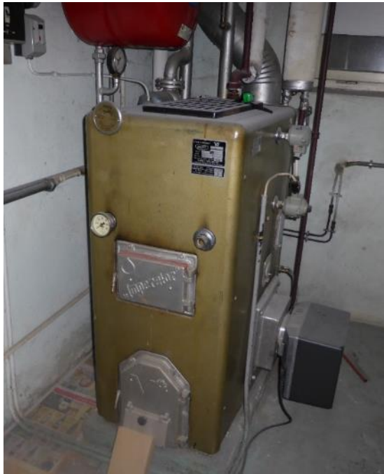
Bild 12 Öl-Kessel aus dem Jahre 1958 (Quelle: EBZ)
