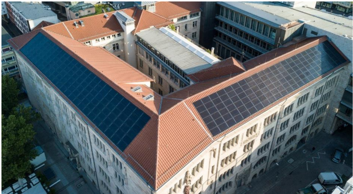
Bild 35 Fertige Indach-Photovoltaikanlage auf dem Rathaus-Altbau
