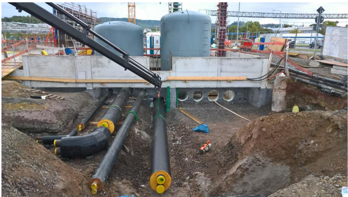
Bild 63 Anschluss der Nahwärmeleitungen
