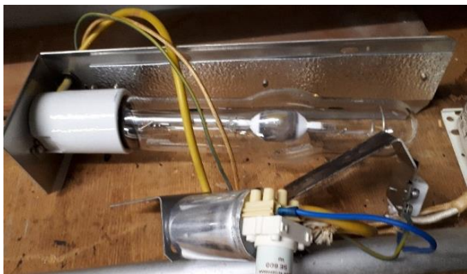
Bild 40 Unterwasserscheinwerfer alter Zustand- 400 W HQI Leuchtmittel
