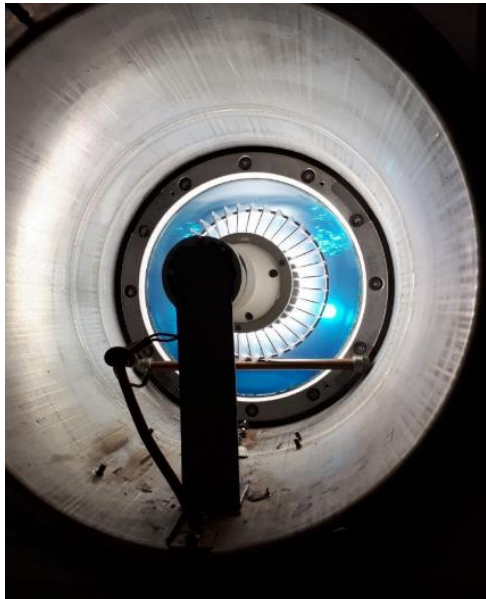
Bild 41 Unterwasserscheinwerfer neuer Zustand- 170 W LED-Leuchtmittel
