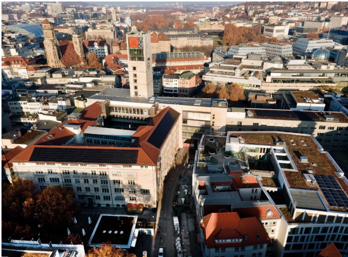
Bild 36 Luftbild des Rathauskomplexes mit den drei städtischen PV-Anlagen (Quelle: Thomas Hörner)
