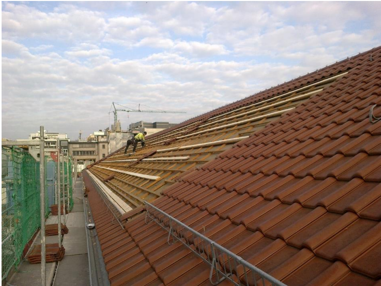
Bild 34 Arbeitsbeginn auf dem Altbauflügel des Stuttgarter Rathauses
