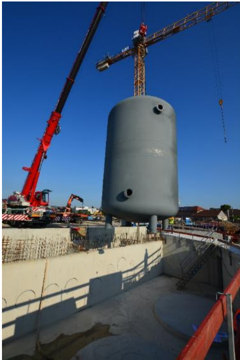
Bild 61 Einbringung Pufferspeicher
