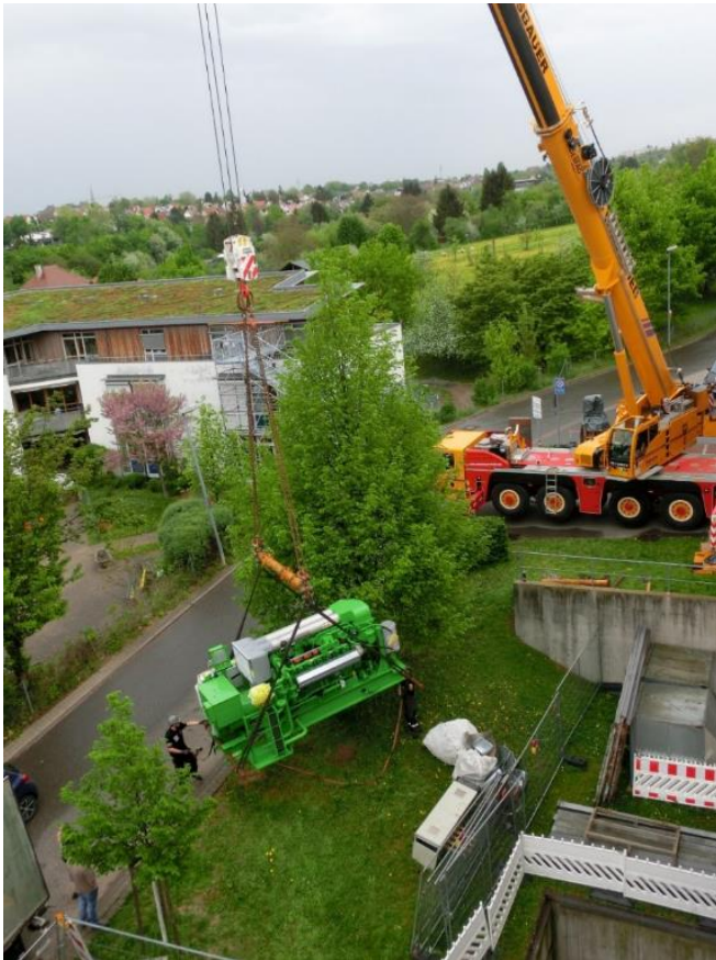
Bild 30 Einbringung des BHKW-Moduls
