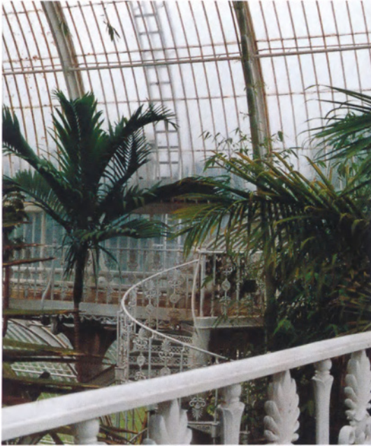
Abb. 2: Innenansicht des Palmenhauses: gusseiserne Wendeltreppe und Dachkonstruktion in viktorianischem Baustil mit Palmen.
