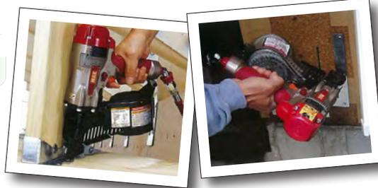
Befestigung von Balkenschuhen und Nagelplatten.
