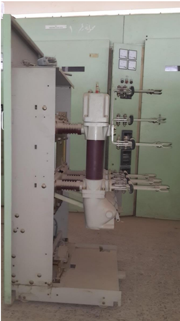
8BD-Schaltwagen mit ölarmer LS 8BD-switch truck with MOCB
