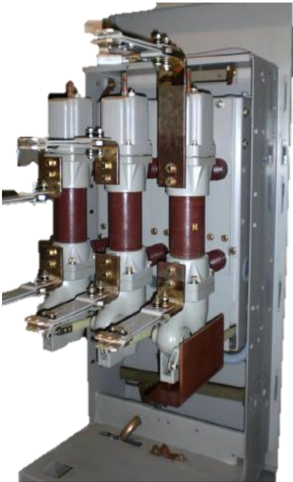
8BC1-Schaltwagen mit H515 ölarmeren LS 8BC1-switch truck with H515 MOCB
