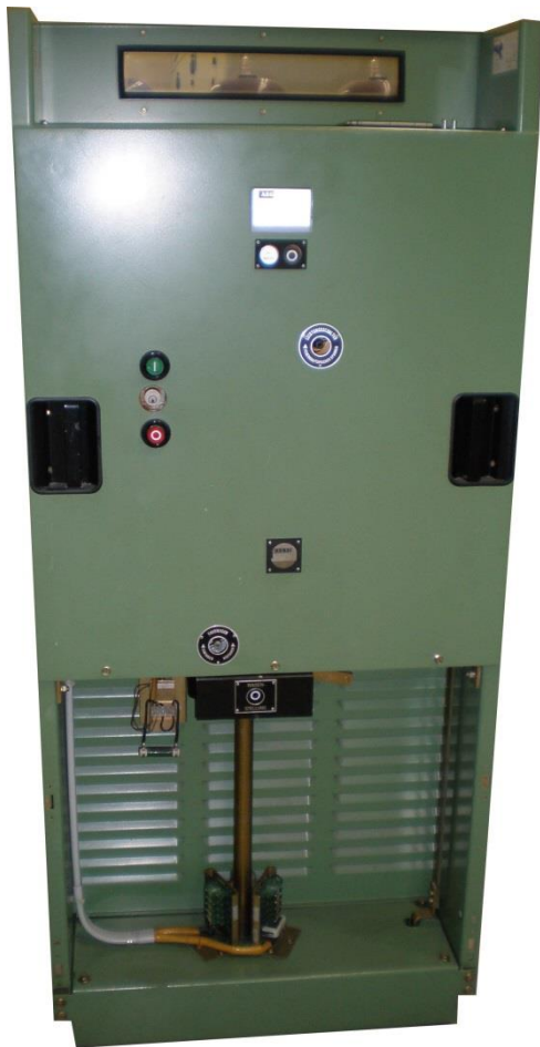
AEG-Schaltwagen mit ölarmer Leistungsschalter AEG-switch truck with MOCB
