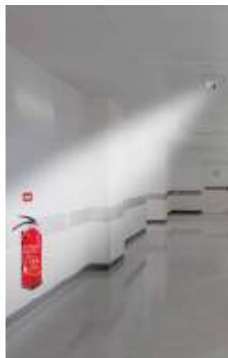
Flächenausleuchtung für 1 lux Symmetrisch 0°-0° Neigungswinkel
