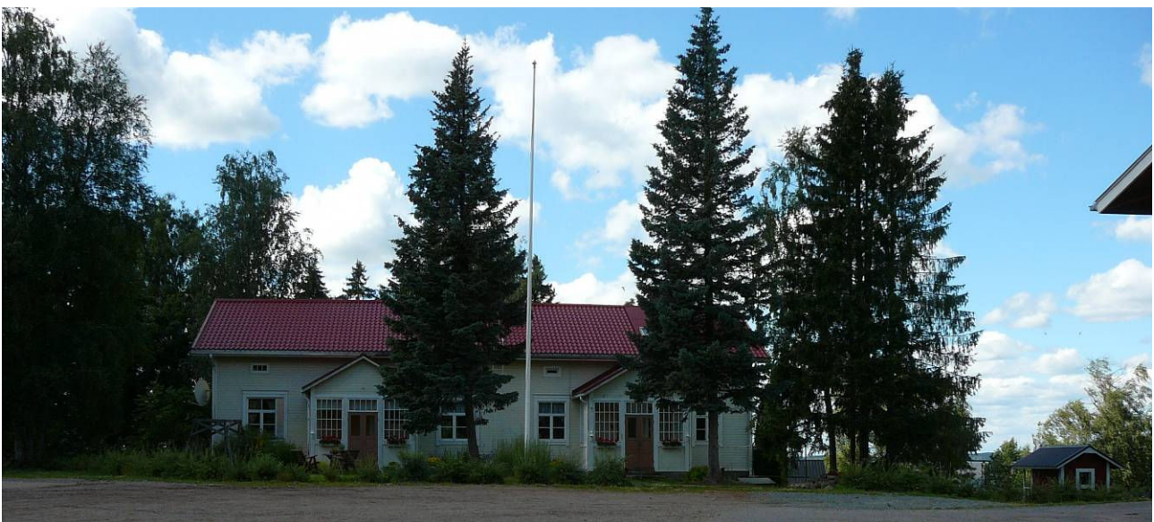
Alikylän vanhaa rakennuskantaa
