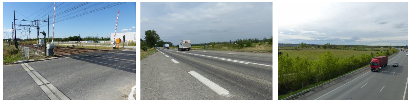
Voie ferrée, N20 et A62 encadrant le site étudié (source : ECTARE)
