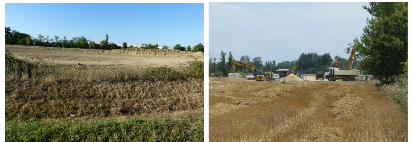
Zones en cours d'aménagement (source : ECTARE)
