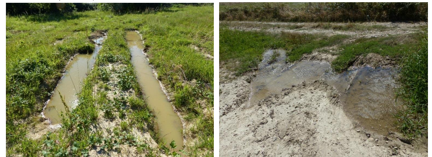
Ornières présentes sur le site (source : ECTARE)
