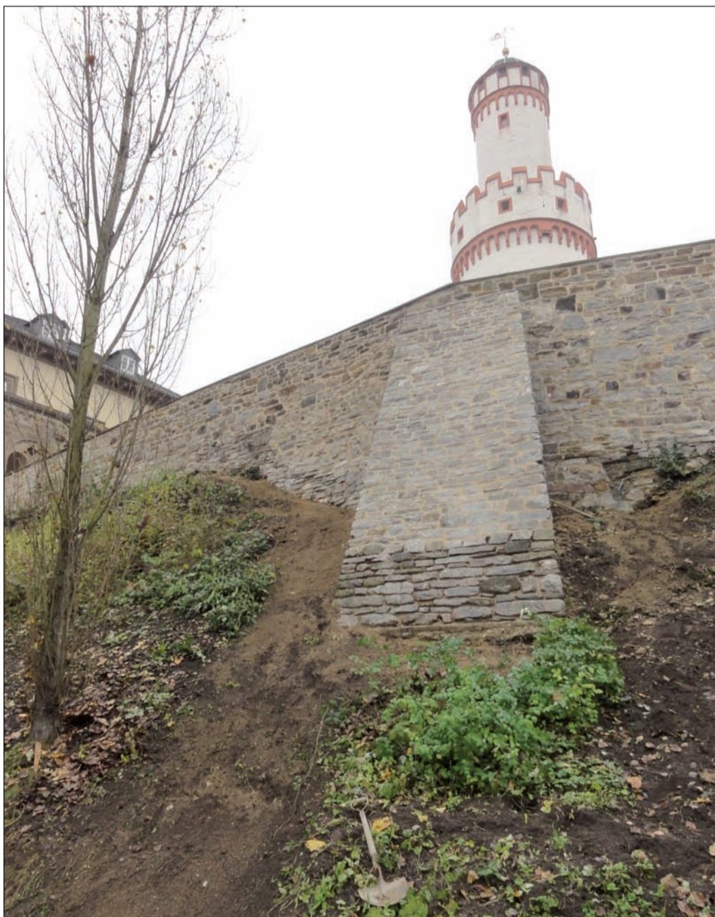
Der hessische Schlossverwaltungsdirektor Karl Weber präsentierte eine Sensation: Bei der Restaurierung der großen Stützmauer des oberen Schlosshofes entdeckten die Bauhistoriker gangartige Höhlen, die unter den Schlosshof führen. Foto: Bergner
