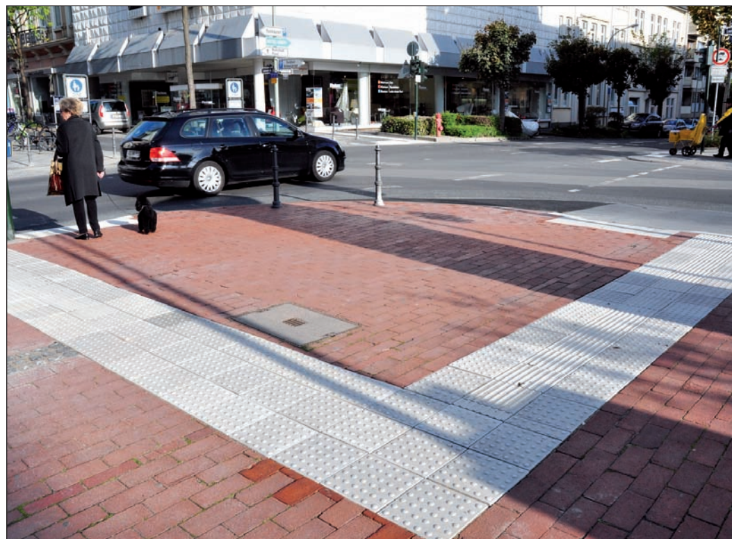
Das Aufmerksamkeitsfeld mit Noppen und Rillen weist Blinden den richtigen Weg. Links daneben befindet sich (im Bildhintergrund) vor dem Überweg die Absenkung für Rollstuhlfahrer.
