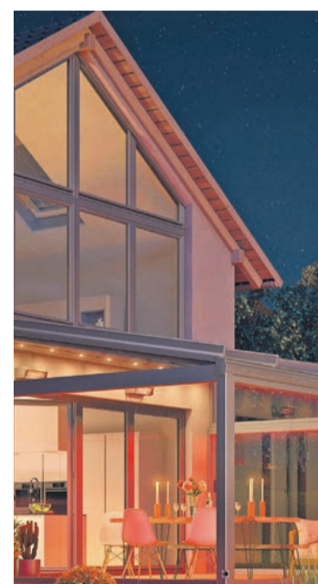
Die richtige Beleuchtung macht aus Terrasse und Balkon nachts den Lieblingsplatz. Foto: djd/weinor.de
