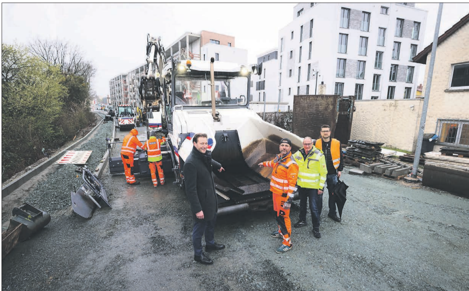
Oberbürgermeister Alexander Hetjes, ein Mitarbeiter der Firma Eurovia, Markus Philipp, Fachbereichsleiter Tiefbau, und Christian Hohn vom Produktbereich Straßenbau (v. l.) auf der Baustelle im Schaberweg. Foto: H. Rhode/Stadt Bad Homburg
